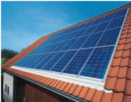
La mise en œuvre de ces systèmes en partie courante signifie que les modules photovoltaïques sont implantés en lieu et place des éléments de couverture mais que certains d'entre eux sont conservés autour du champ photovoltaïque.
