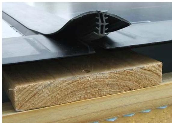
Figure 31: Joint d'étanchéité entre deux panneaux.
