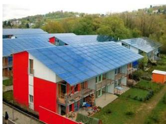
La mise en œuvre de ces systèmes peut également être réalisée sur l'ensemble de la couverture (c'est-à-dire champ photovoltaïque mis en œuvre jusqu'à l'égout, faitage et rives du bâtiment).
