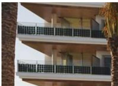
Dans le cas d'une installation photovoltaïque pour constituer un balcon, les modules photovoltaïques sont mis en place en lieu et place des éléments de remplissage classiquement utilisés. Pour répondre aux exigences en termes de sécurité lié à cet usage, les **modules se doivent d'être des vitrages photovoltaïques** utilisant un composant feuilleté de sécurité.
