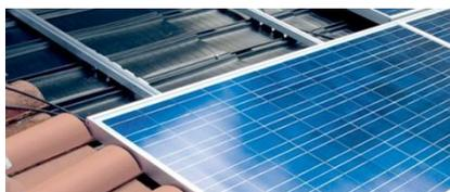
La mise en œuvre de ces systèmes en partie courante signifie que les modules photovoltaïques sont implantés en lieu et place des éléments de couverture mais que **certains d'entre eux** sont conservés autour du champ photovoltaïque.
