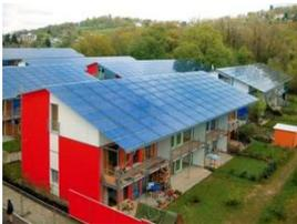
La mise en œuvre de ces systèmes peut également être réalisée sur l'ensemble de la couverture complète (c'est-à-dire champ photovoltaïque mis en œuvre jusqu'à l'égout, faîtage et rives du bâtiment).
