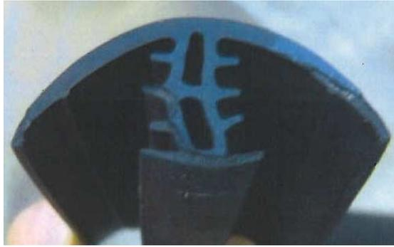
Figure 30: Joint d'étanchéité entre deux panneaux.
