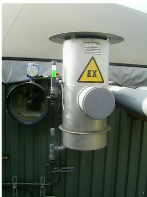
Exemple de soupape de sécurité.
