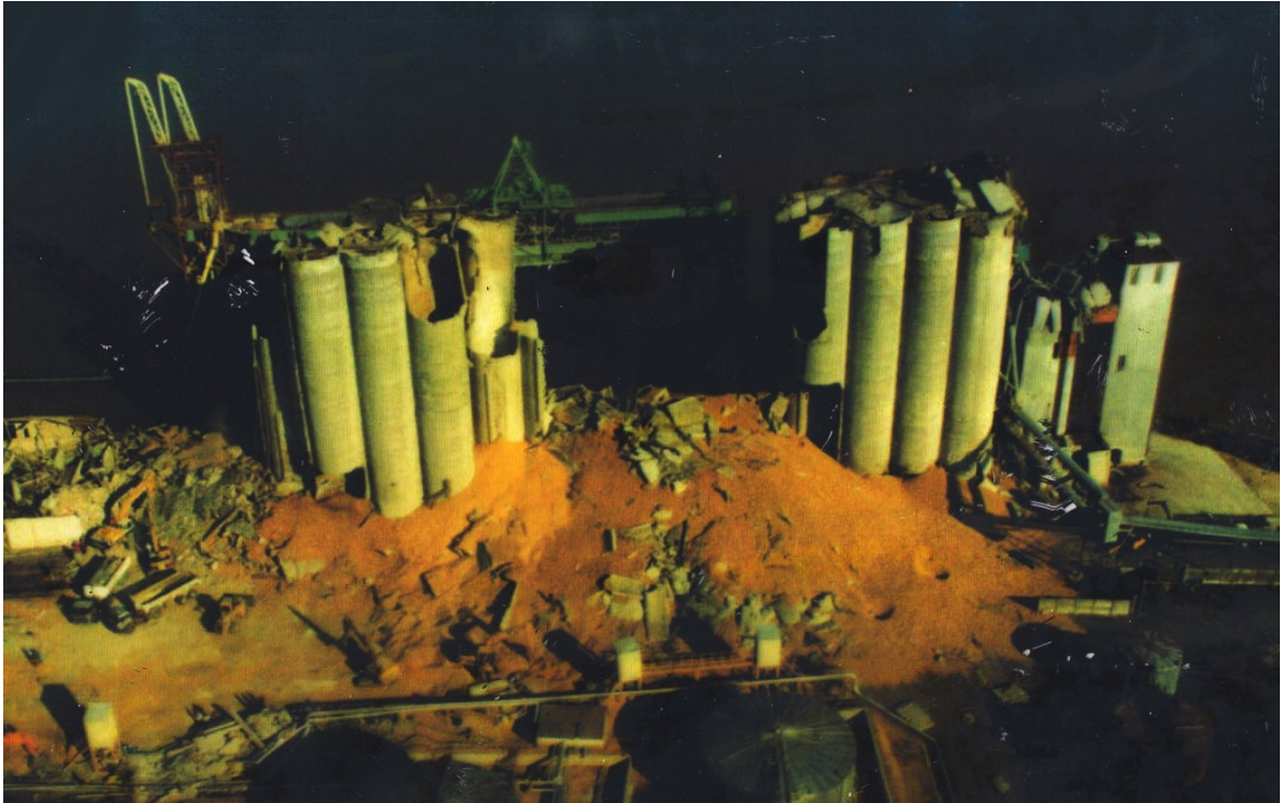
Figure 2 : vue de l'installation de stockage de Blaye après l'accident
