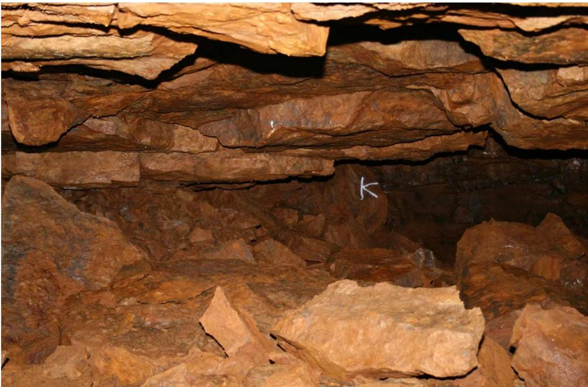
Figure 15 : Chutes de toit dans la zone à risque de fontis de la mine de Moyeuvre.
