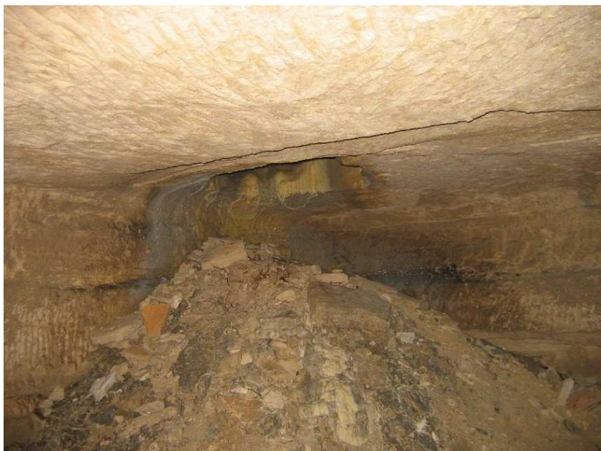
*Figure 22 : Démarrage de fontis dans la carrière de calcaire grossier (site E).*
