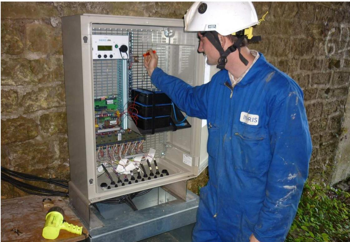
Figure 18 : Unité d'acquisition (type SYTGEM VLP, INERIS) installée sur le site pilote d'Hayange.
