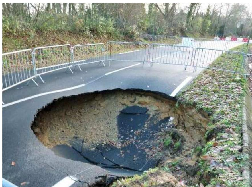
Figure 2 : Fontis débouchant sur une route, dans le massif de l'Hautil (Véxin), depuis une carrière de gypse sous-jacente (source photo : Mediaseine).
