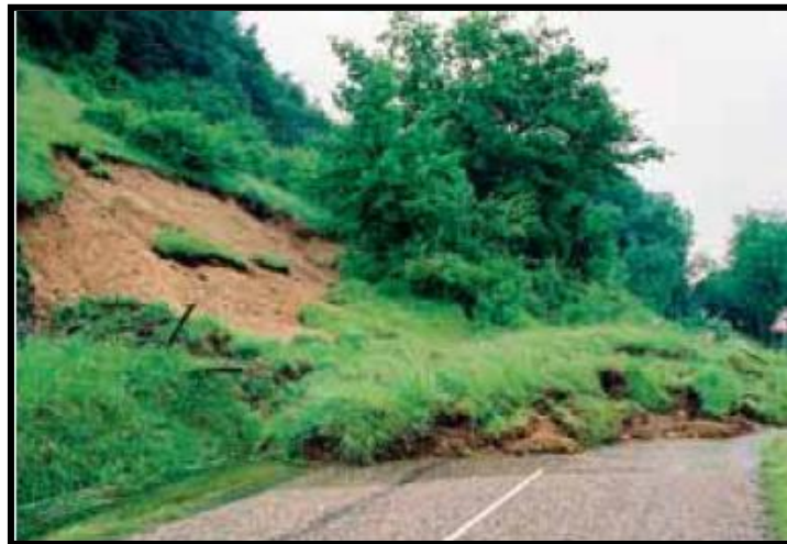
Figure 3 : Glissement plan sur la RD 28 en 2002 à Merlas (Isère, 38)
