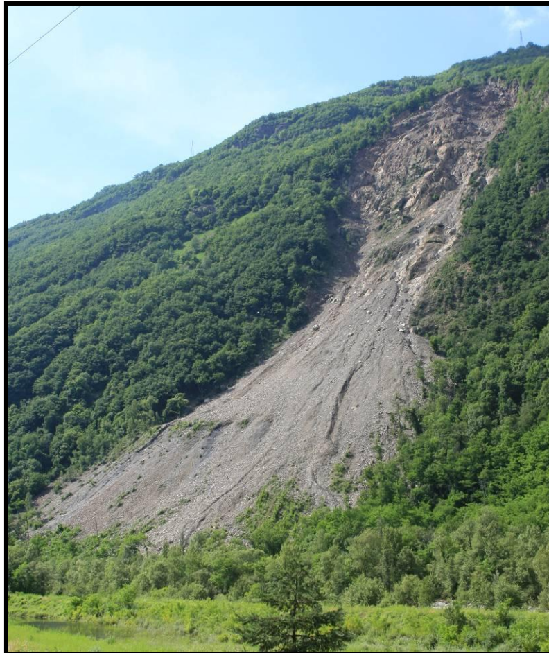
Figure 4 : Glissement de Séchilienne, (Isère, 38)
