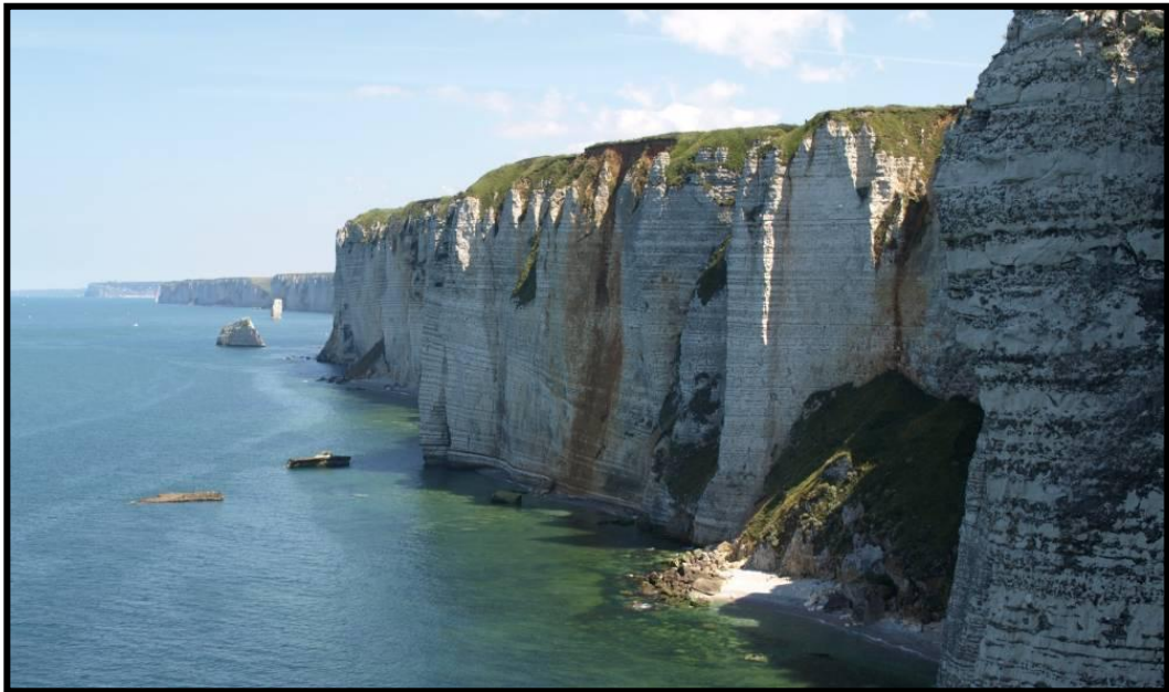
Figure 11 : Falaises à proximité d'Etretat en Seine Maritime (76)
