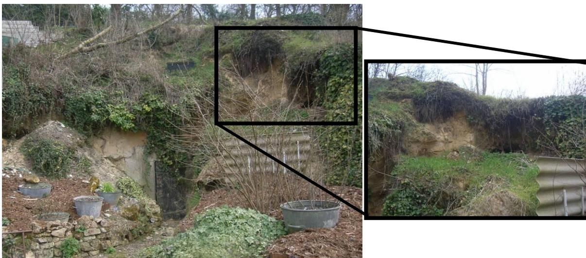
Figure 16 : Décollement de matière observable sur le front de coteau
