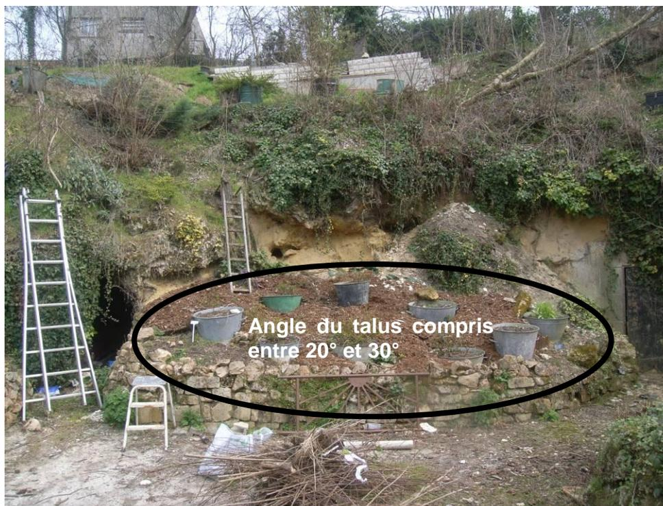
Figure 17 : Mise en évidence du talus au pied du coteau
