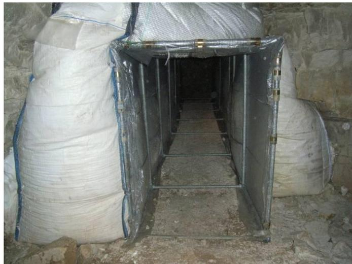
*Photographie 7 : Tunnel réalisé dans une zone remblayée permettant le passage d'un secteur de carrière vers un autre*
