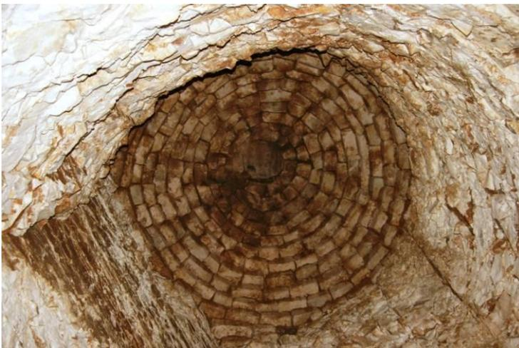
*Photographie 3 : Fermeture d'une catiche par un encorbellement de moellons*
