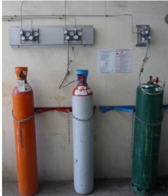
Photo 2 : Bouteilles de gaz pour l'hydrogène, le méthane & le propane
