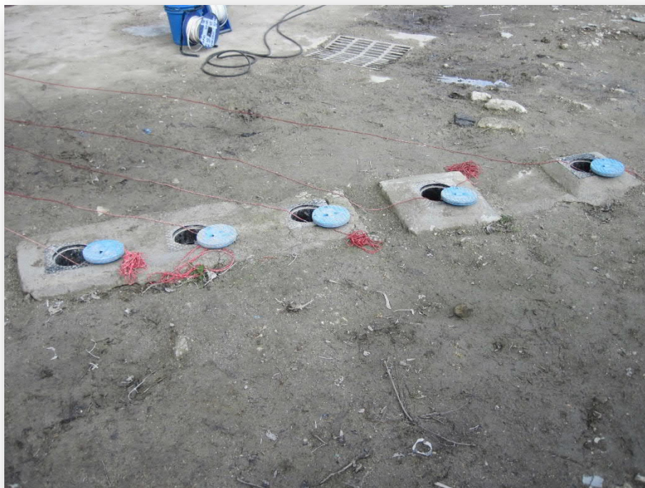
Figure 9 : Piézomètres en « flûte de pan » (source : Ineris)
