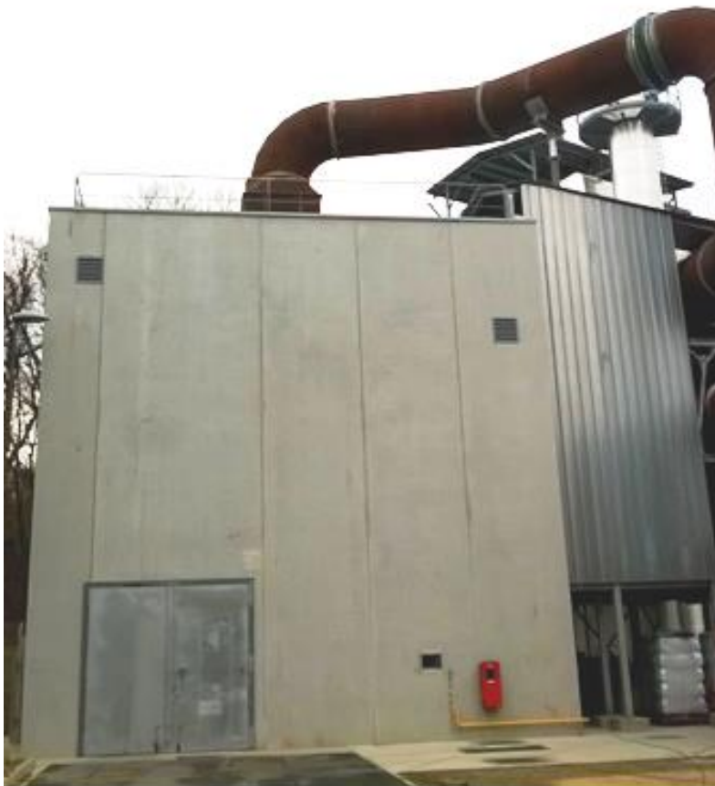
Figure 11 : vue extérieure de la chambre de combustion 1000 m 3 .
