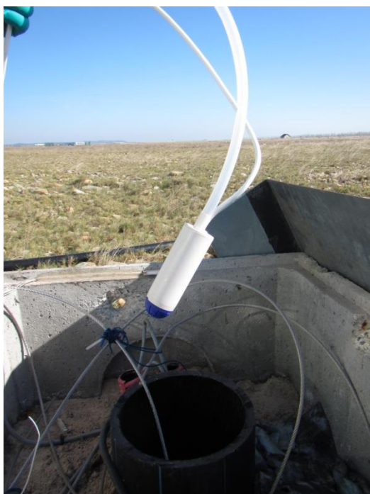
Figure 5 : Pompe Gigant utilisée sur un puits de la plaine de la Crau (INERIS)
