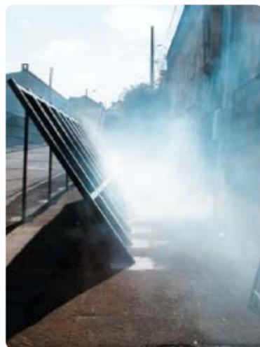
**PHOTO 1.** Aménagement préventif d'une galerie minière ouverte. La sortie de gaz de mine est visualisée à l'aide de fumigène.
