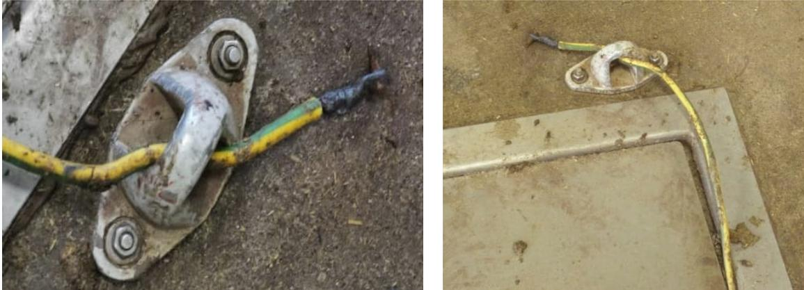
**Tableau 8 : Vues de cas de la problématique de l'oxydation des câbles et tresses ainsi que leurs accessoires de fixation (pattes, écrous etc.) sur des installations de méthanisation**
