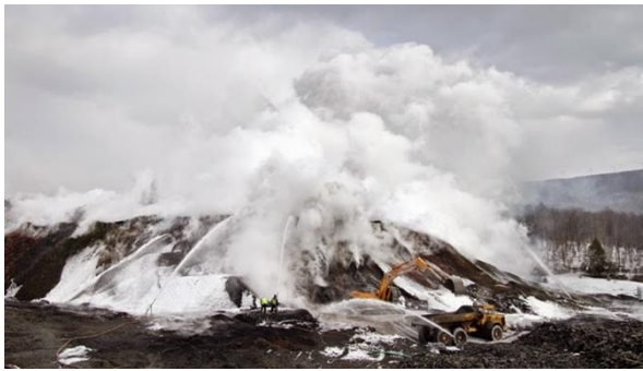
Etats-Unis : essai d'extinction d'un terril en combustion près de Simpson en Pennsylvanie (Gibbons, 2014)
