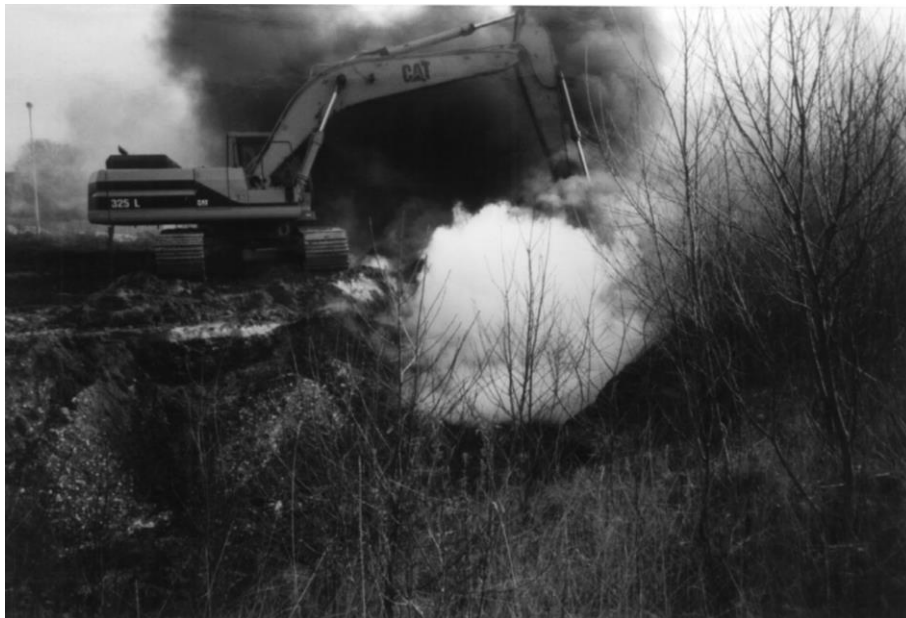
Excavation du banc de résidus houillers de Brymbo au pays de Galles (Nichol et Tovey, 1998)
