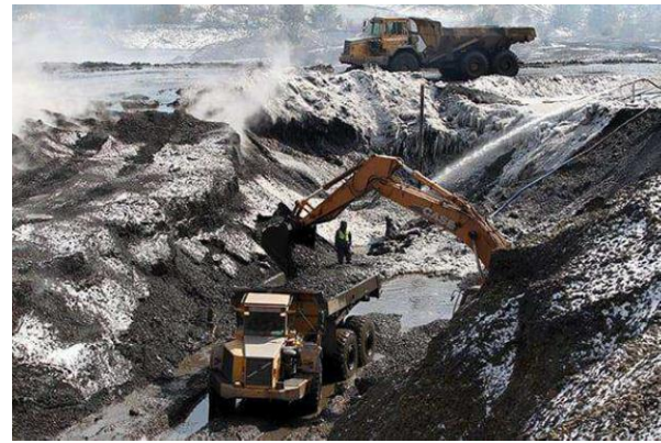
Etats-Unis : essai d'extinction d'un terril en combustion près de Simpson en Pennsylvanie (Gibbons, 2014)
