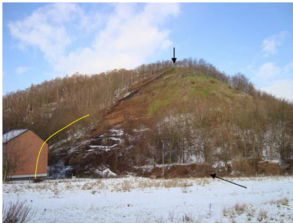
Figure 19. Glissement du flanc du terril de Petite Bacnure photographié en 2010 (Nyssen et al., 2012)
