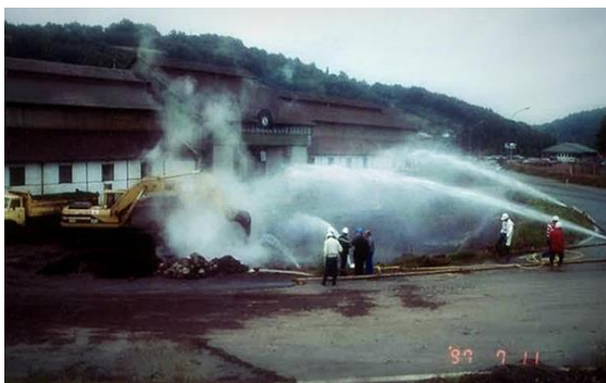
France : traitement d'une plate-forme de remblais houillers et sidérurgiques entrée en combustion en 1997 à Decazeville (Aveyron) par terrassement, injections spéciales et soutènement ( http://sylvain-post.blogspot.com/2012/10/echauffements-de-schistiers-plusieurs.html )
