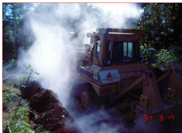
Creusement d'une tranchée coupe-feu en 1997 sur la Verse des Prés à Cransac, Aveyron (Paquette et Degas, 2016)
