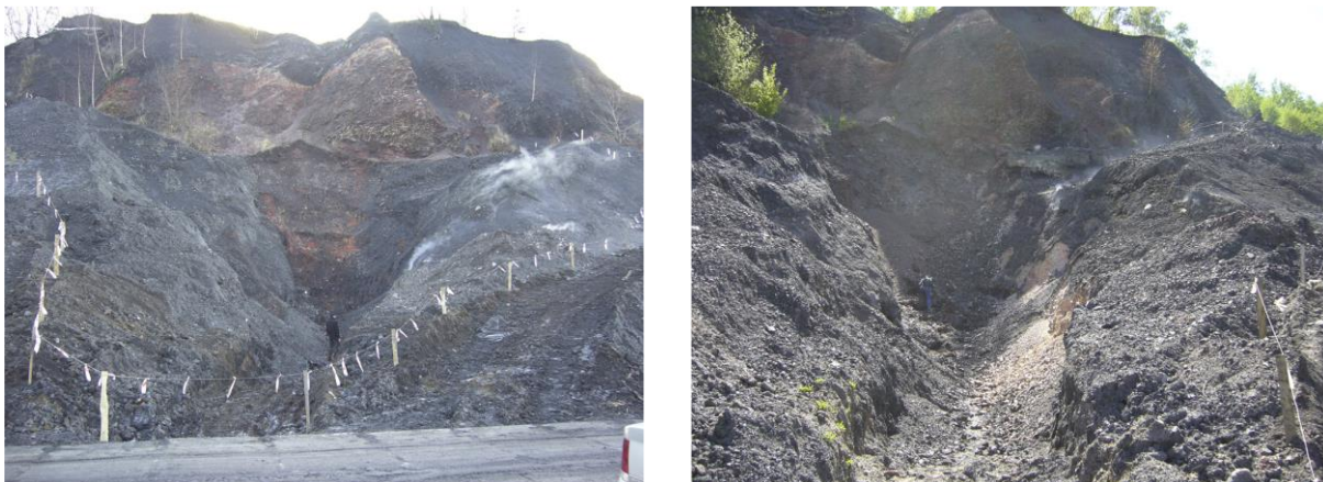
Vue d'ensemble (à gauche) et en détail (à droite) des excavations réalisées en 2008 pour éteindre le feu du terril de Starzykowiec (Misz-Kennan et Tabor (2015)
