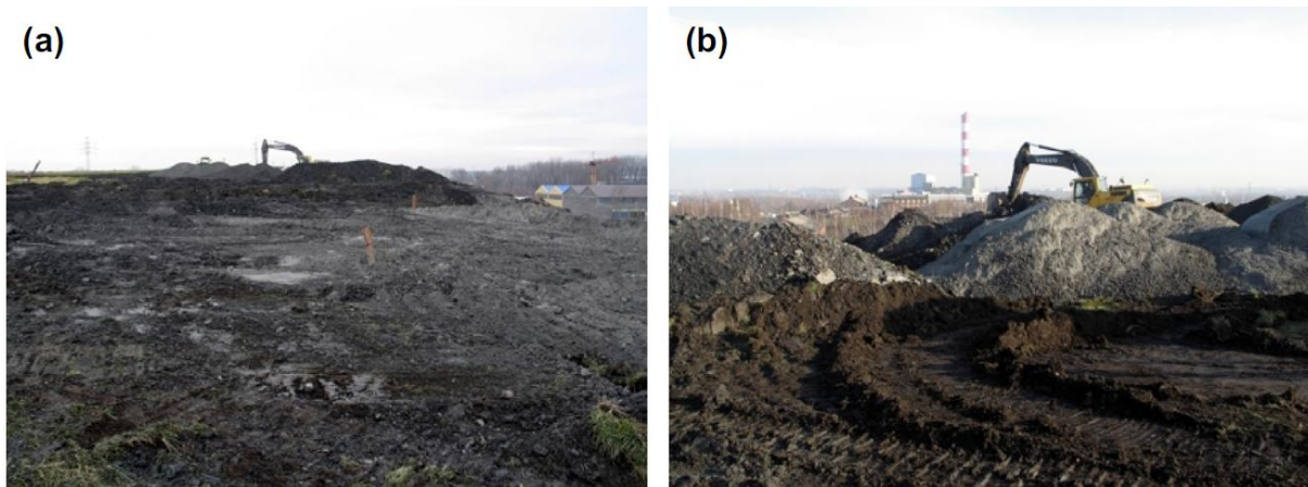
Revégétalisation du sommet d'un terril houiller en combustion (a) et recouvrement par une couche de cendres volantes (b) à Wełnowiec près de Katowice (Ciesielczuk, 2015a)
