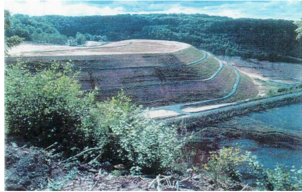
b) Vue générale du site réhabilité
