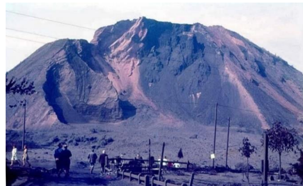
Figure 18. Vue du terril n°6 d'Auchel à Calonne-Ricouart avant (à g.) et après (à d.) son écroulement (Noter, sur la photo de gauche, la masse sommitale compacte de résidus brûlés, de couleur rougeâtre, à l'interface de laquelle s'est produit l'écroulement)
