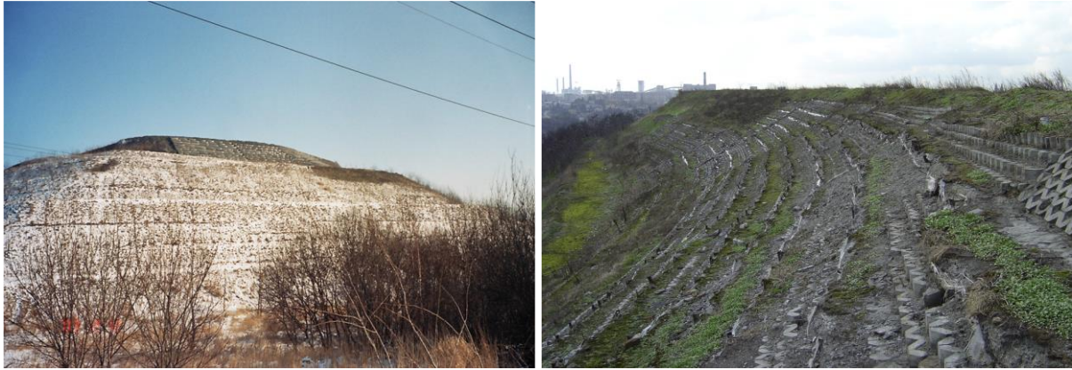
Tentative de scellement du terril Rymer Cones en Pologne par des plaques de béton et des cendres volantes (à gauche) et vue du sommet (à droite) (Misz-Kennan et Tabor, 2015)
