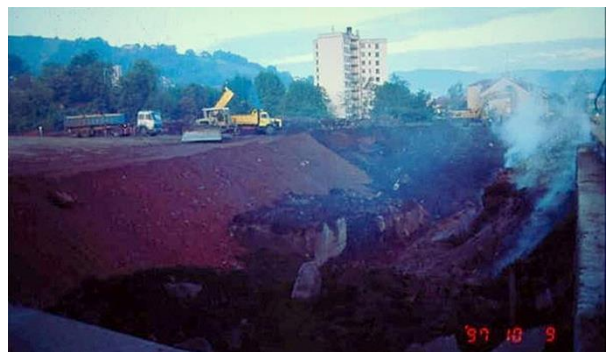
France : traitement d'une plate-forme de remblais houillers et sidérurgiques entrée en combustion en 1997 à Decazeville (Aveyron) par terrassement, injections spéciales et soutènement ( http://sylvain-post.blogspot.com/2012/10/echauffements-de-schistiers-plusieurs.html )
