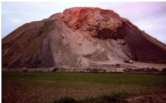
Figure 18. Vue du terril n°6 d'Auchel à Calonne-Ricouart avant (à g.) et après (à d.) son écroulement (Noter, sur la photo de gauche, la masse sommitale compacte de résidus brûlés, de couleur rougeâtre, à l'interface de laquelle s'est produit l'écroulement)
