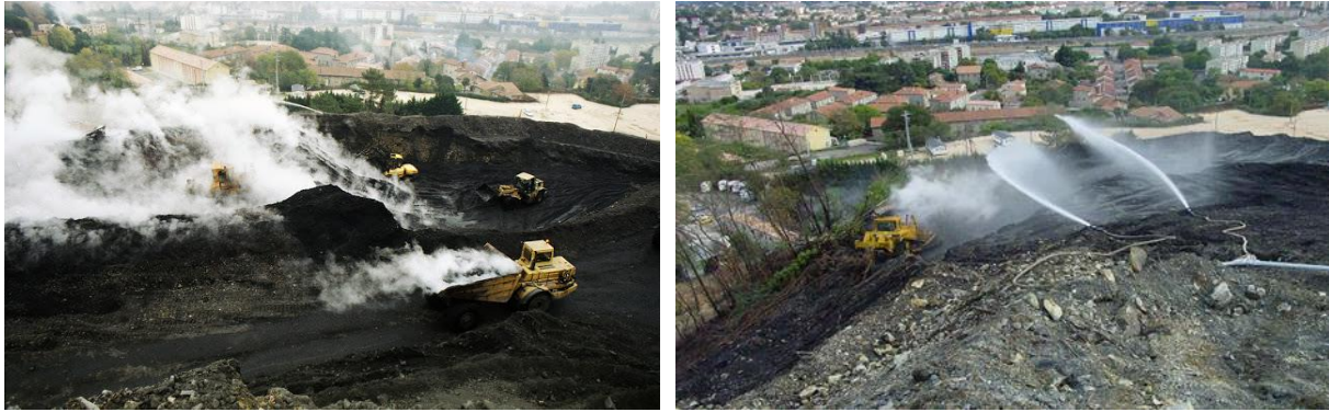
Vue des opérations de défournement du terril de Rochebelle près d'Alès
