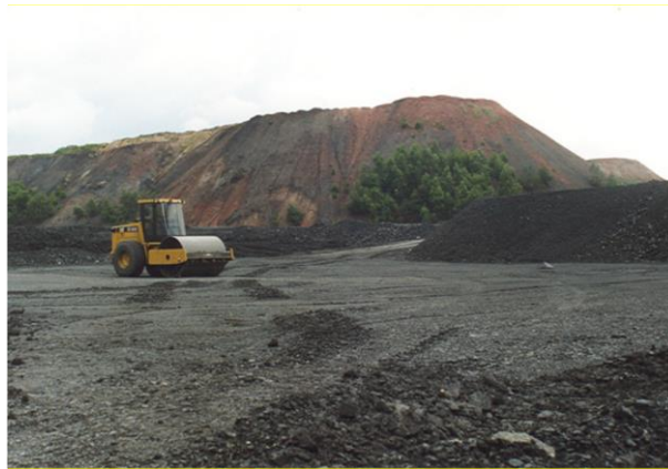
Compaction des résidus récents du terril Marcel par « rouleau vibreur »
