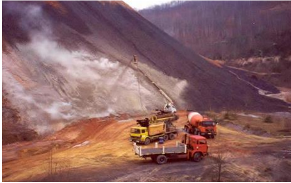
a) Projection de coulîs sur les flancs du terril
