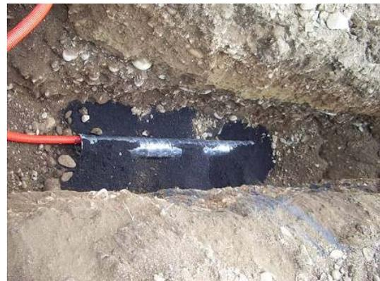
**Figure 8** Pose d'une anode prébackfillée
