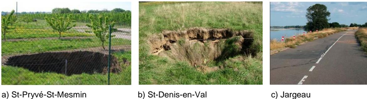
Figure 8. Exemples d'effondrements en terrain cohésif (a) ou peu cohésif (b) et d'affaissement (c) dans le Val d'Orléans
