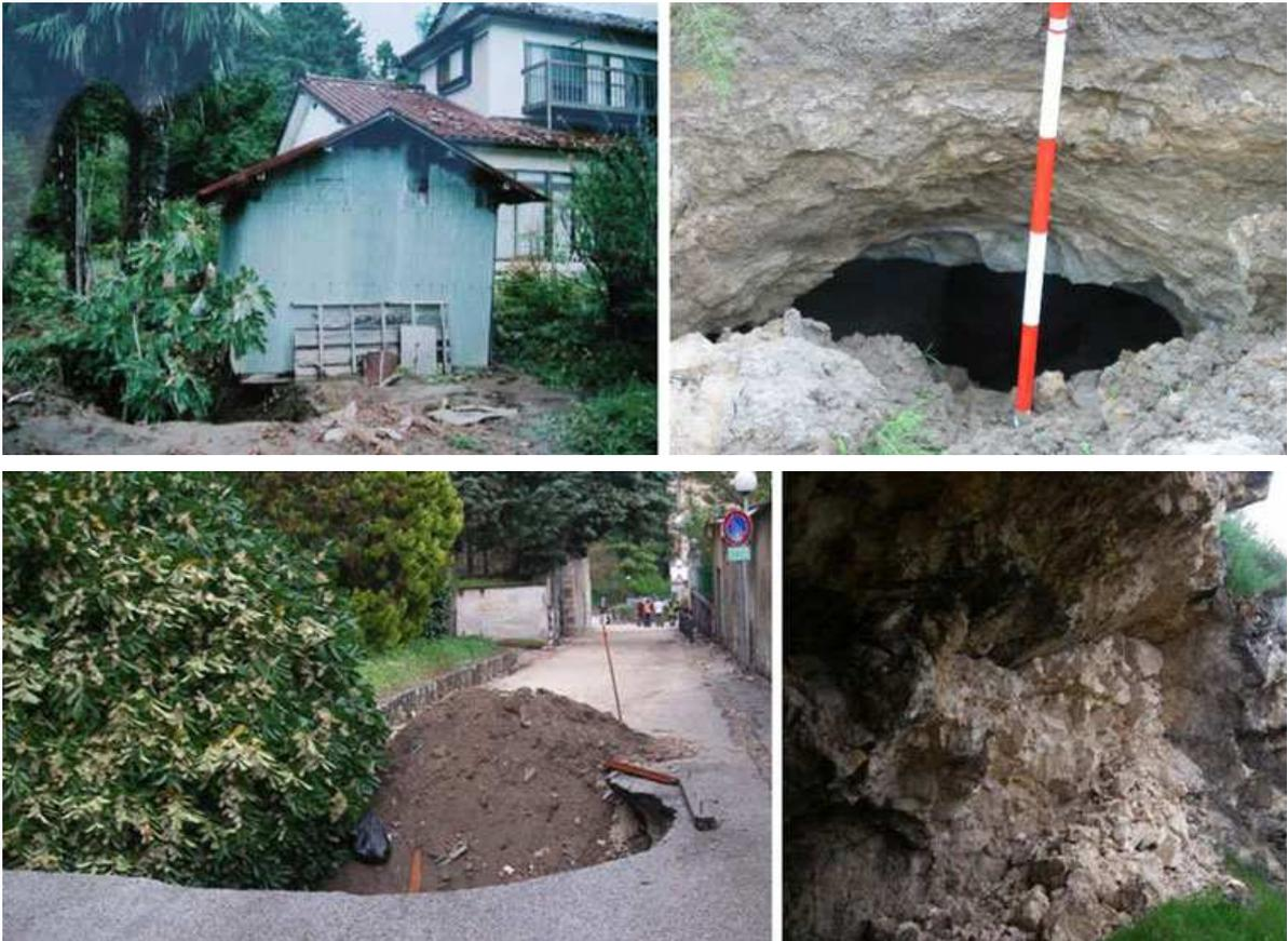
Figure 26 : Exemples d'effondrements de cavités souterraines causés par des séismes : (en haut) sous-cavage dans la mine abandonnée de Yamoto (Japon) (Kawamoto, 2004) ; en bas : fontis à l'Aquila (Italie) (Aydan et al., 2009).
