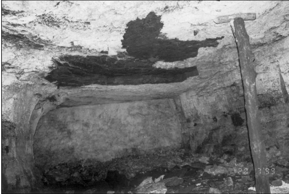
Figure 22 : Chutes de toit dans la recette d'une mine de charbon suite à des explosions à proximité (Singh, 2002), le toit est composé de grès, la mine se situe à environ 150 m de profondeur.
