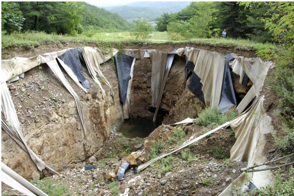
*Figure 1 : Effondrement d'une cavité de la mine de Toehyun (Corée du Sud) suite au séisme de Andong de 2009 (magnitude de 3,8) à 35 km (Waltham et al., 2011).*
