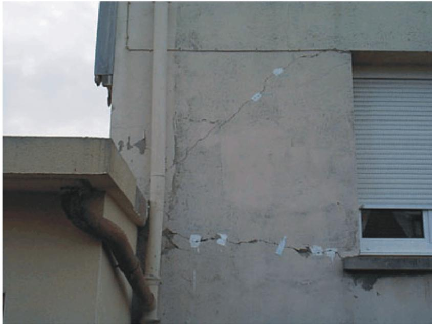
*Figure 35 : Illustration de dommages fonctionnels*
