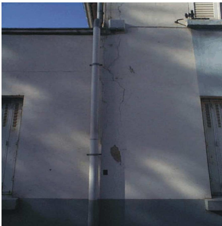
*Figure 34 : Illustration de dommages architecturaux*
