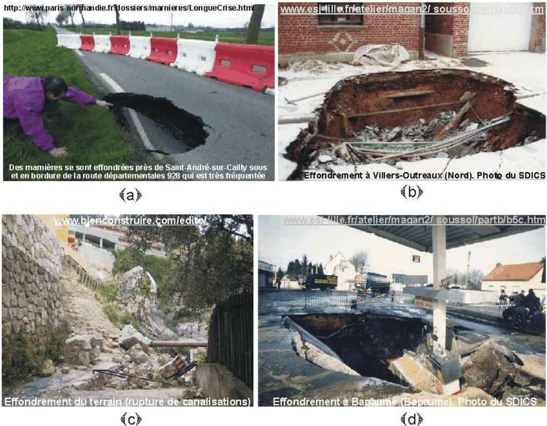
Figure 18 : Différents types de dommages induits par des fontis.
