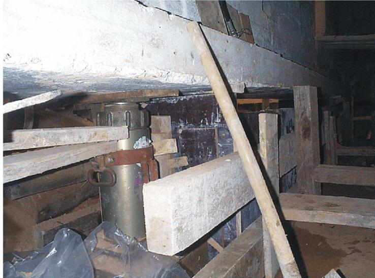
Figure 24 : Renforcement des fondations après relevage (HBL)
