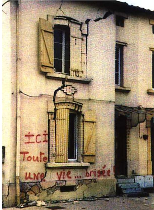
Figure 6 : Rupture par extension
