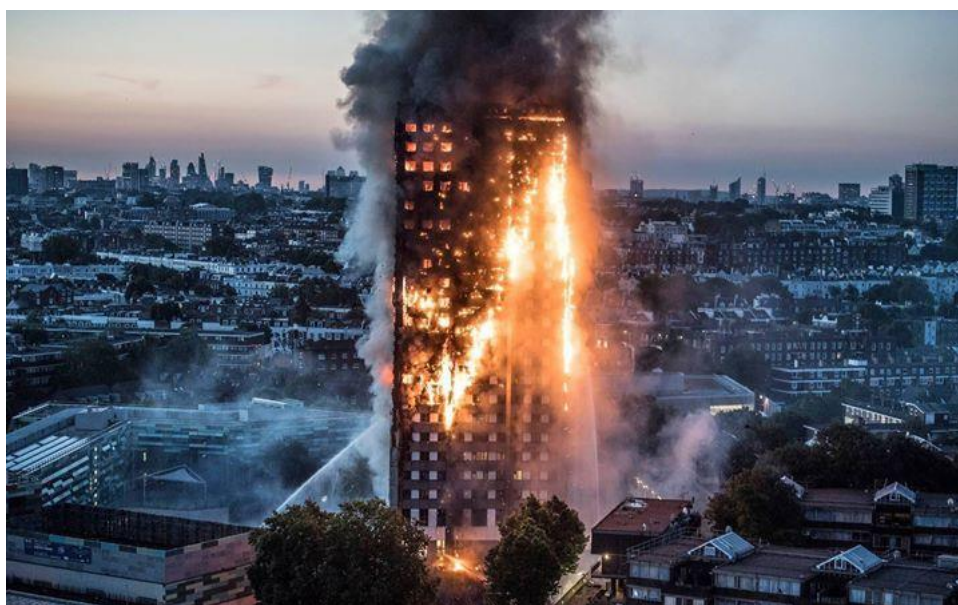
Figure 7. Incendie de la tour Grenfell / juin 2017
