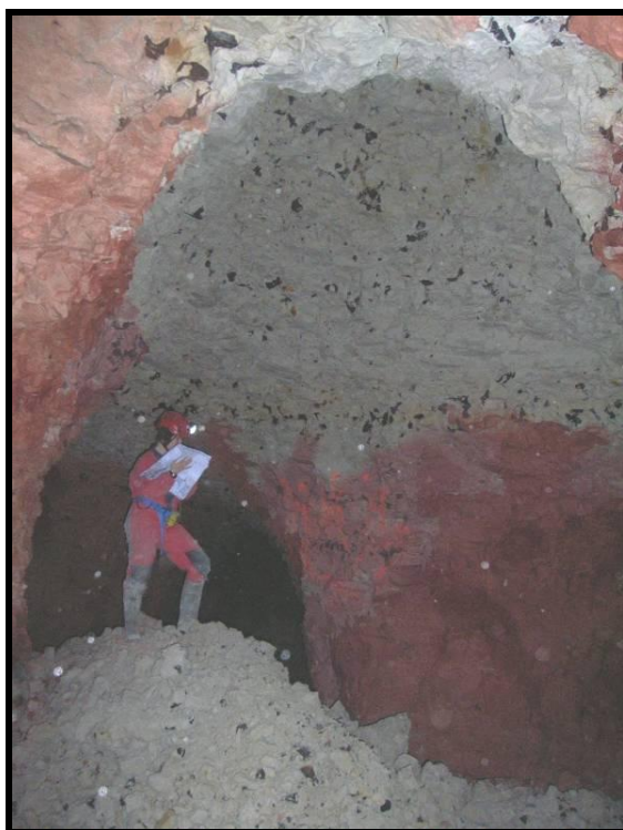
Photographie 2 : Montée de voûte évolutive dans la carrière du Chemin Vert (MV13, Photo 201)
