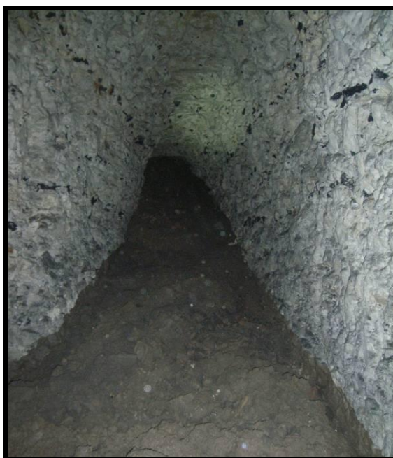
Photographie 3 : Coulée de terre visible suite au traitement en surface de l'effondrement de novembre 2010 (Photo 206)
