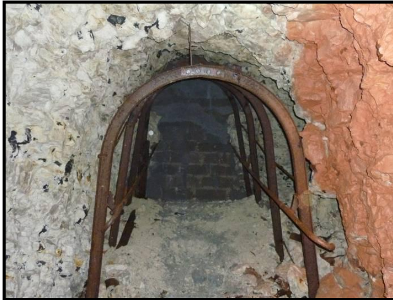
Photographie 10 : Mur en parpaings bloquant l'ancien accès PA2 (Photo 475)
