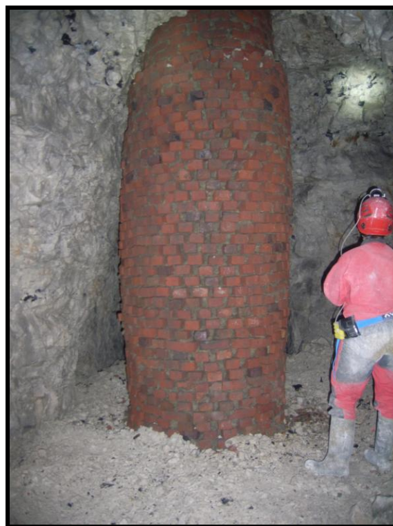
Photographie 5 : Gonflement du parement du puits P1 (Photo 254)
