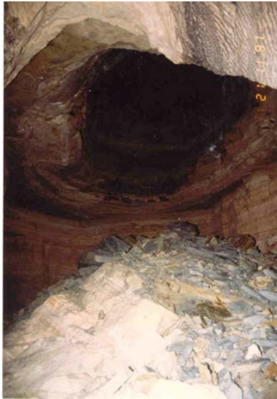
Photo 1 : Cône d'éboulis : à gauche, marnes sèche, à droite le même matériau sous l'effet de l'eau.
