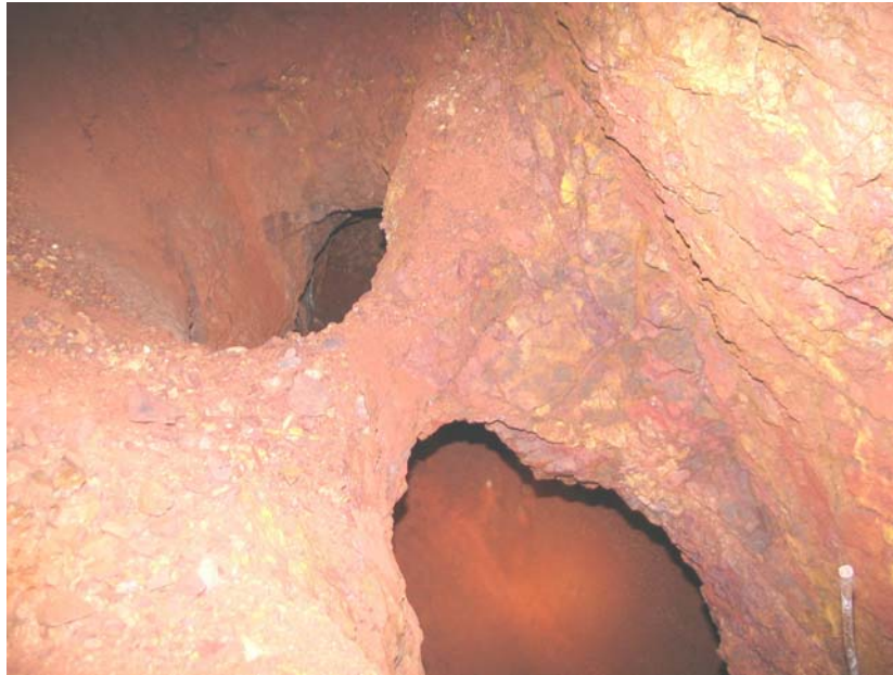
Photographie 1 : Dégradation d'un pilier dans une exploitation pentée par chambres et piliers (May-sur-Orne, 14)
