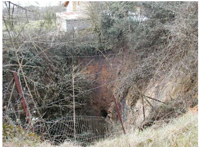
Figure 31 : Effondrement d'une « couronne » d'une exploitation par chambres-magasins (exemple des Aulnais au droit de la mine de Segré, 49)
