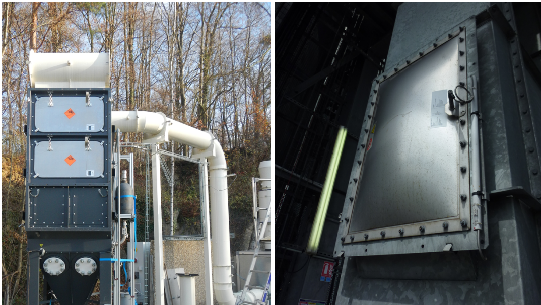
Figure 1 : Exemples d'événements d'explosion installés sur un filtre (à gauche), ou un élévateur (à droite)
