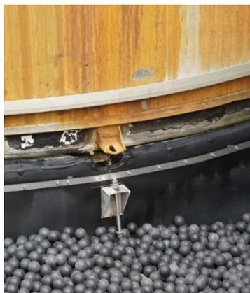
c. Rupture d'ancrages au sol
