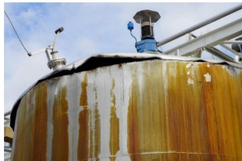
b. Déchirure de la soudure du dôme
