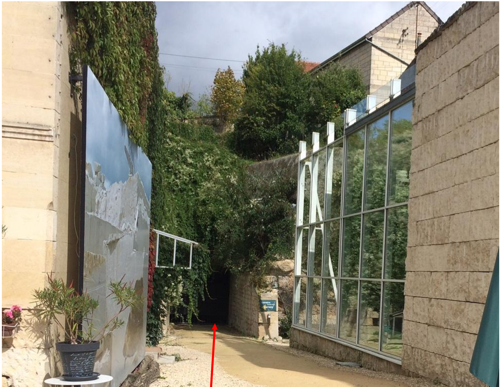
Entrée par bouche de cavage ouverte au 16 ème siècle
