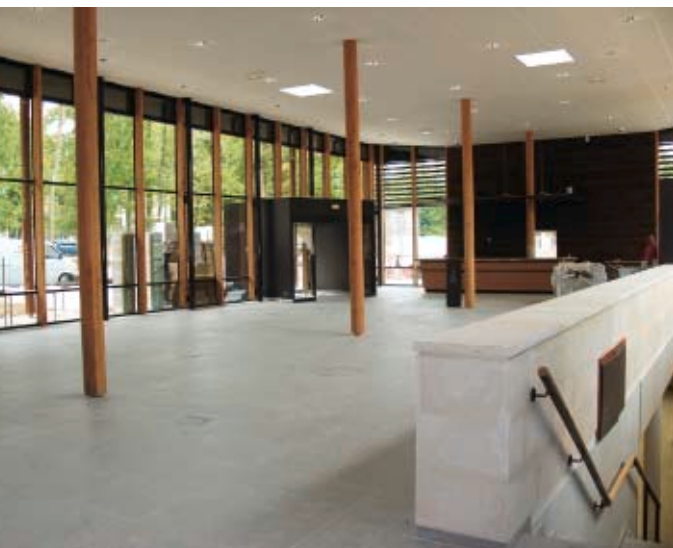
Le futur hall d'accueil de l'INERIS à Verneuil-en-Halatte.
