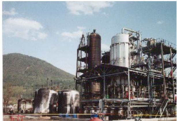
L'oxygène formé a provoqué la montée en pression des installations et l'éclatement d'une tuyauterie de liaison dépourvue de soupape ou autre dispositif équivalent. La masse réactionnelle qui se vide partiellement des appareils de production, s'enflamme sur un point chaud.
