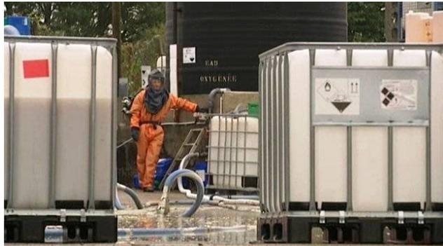
Les conséquences: **Dispersion de produit chimique comburant, corrosif et irritant** dans la cuve de rétention et en raison d'un défaut d'étanchéité dans le bassin de collecte des eaux pluviales et industrielles.
