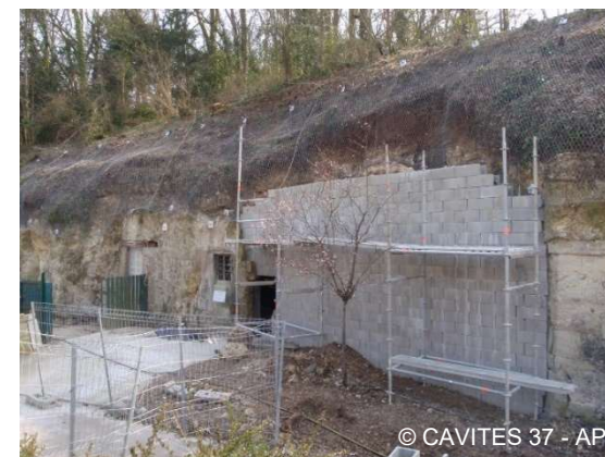
ROCHECORBON(37) – Soutènement et grillage
