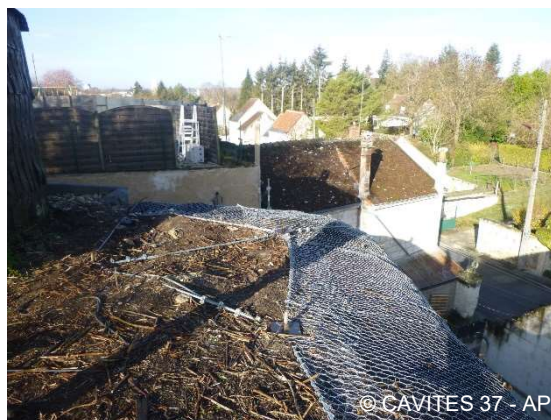
BEAULIEU LES LOCHES (37) – Grillage
