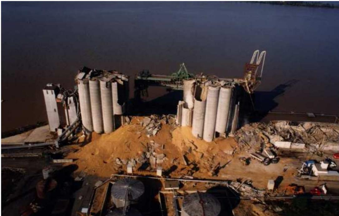
Figure 6 : Silo de Blaye après l'explosion du 20/08/1997 (extrait de la fiche détaillée ARIA du BARPI téléchargeable sur <http://www.aria.developpement-durable.gouv.fr> , accident n°11657)
