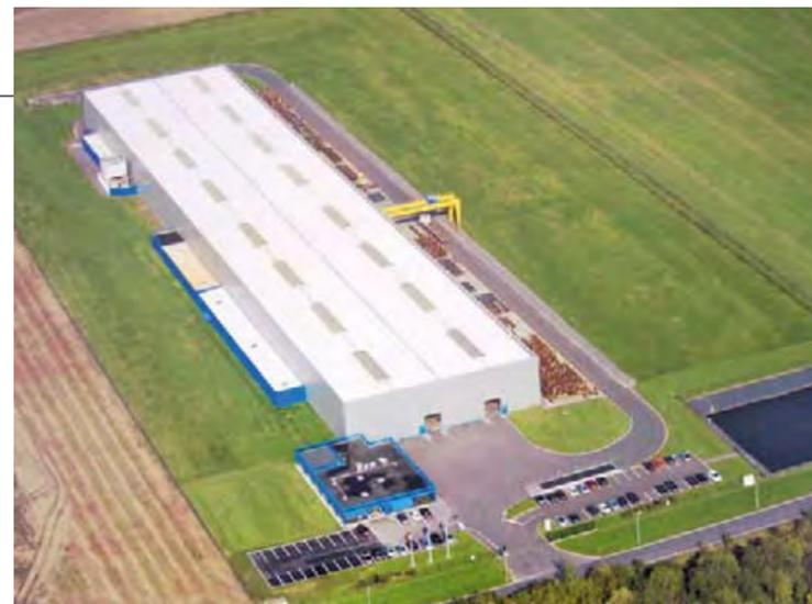
« La GTM France, spécialisée dans le traitement thermique de barres en acier et tubes au carbone ou allié, a sollicité Crédit Coopératif Lease pour la construction d'un site à Denain. Il s'agit d'un bâtiment atypique formé de 2 grandes travées en longueur qui permettent le traitement thermique de métaux très longs », explique Richard Kurfurst.
