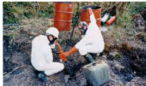
Les techniciens vident à l'aide d'une pompe à main la substance stockée dans un fût enterré avant qu'il ne soit extrait du sol à la pelle mécanique
