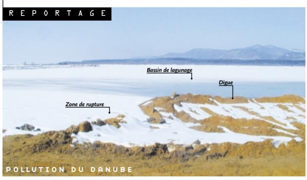
Quelques semaines anrès l'accident. l'équipe de l'INERIS s'est rendue sur le site de l'usine de traitements de minerai Aurul SA de Baia Mare. On distingue bien le bassin de lagunage, la digue en terre et la zone de rupture provoquée par les pluies diluviennes, . à l'origine de la pollution.
