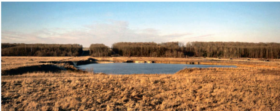
**L**e 13 février 2009 à 5h45, une grande cavité souterraine s'effondre. La cavité est issue de la dissolution de sel dans la concession minière Solvay de Cerville-Buissoncourt, près de Nancy (Meurthe-et-Moselle). L'INERIS y a installé, dès 2005, un système de surveillance automatique fondé sur l'écoute microsismique complétée d'un dispositif de mesure des mouvements des terrains de surface : tachéomètre, balise GPS au centre supposé de la zone d'effondrement.
