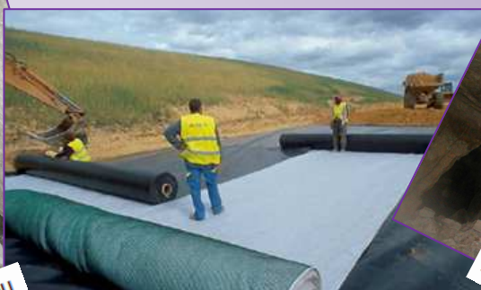
Mise en place d'un géosynthétique
