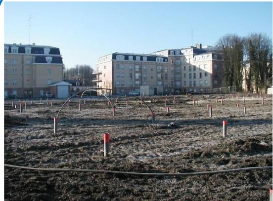
Forages réalisés suivant une maille au niveau d'une zone sous-cavée
