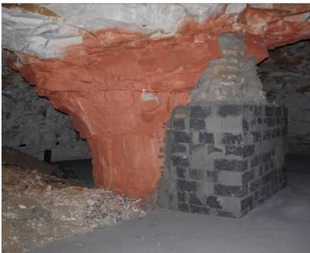
Reprise d'un pilier par maçonnerie
