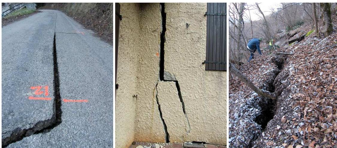
Figure 14 : Effondrement de la carrière de Vicat à Saint Martin le Vinoux le 9 Janvier 2011 à 23:07 (TU). Exemple de désordres observés en surface (source OMIV).
