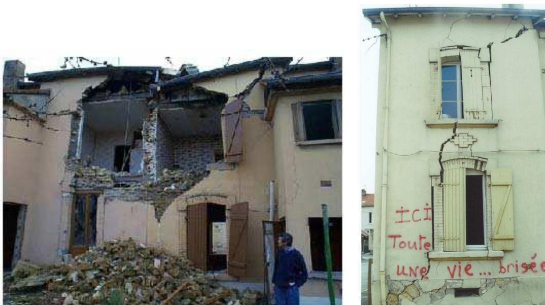
Figure 1 : Exemple de dégâts sur le bâti observés dans le bassin ferrifère lorrain sud, après l'occurrence des effondrements miniers dans les années 1990.
