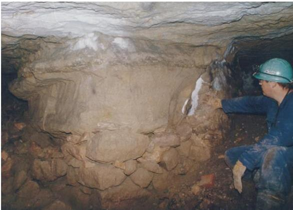
*Photographie 9 : Pilier naturel conforté en maçonnerie sèche dans une carrière de calcaire à Laon (02)*
