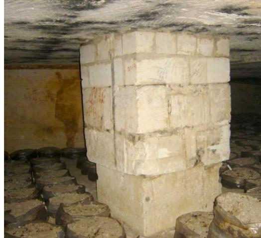
*Photographie 12 : Pilier naturel conforté dans une carrière de calcaire à Sireuil (16)*
