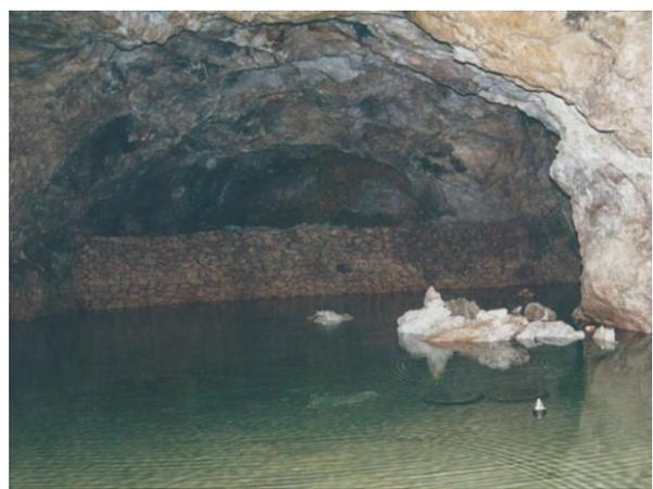
*Photographie 14 : Murs de barrage dans une carrière de pierres à ciment à Roquevaire (13)*
