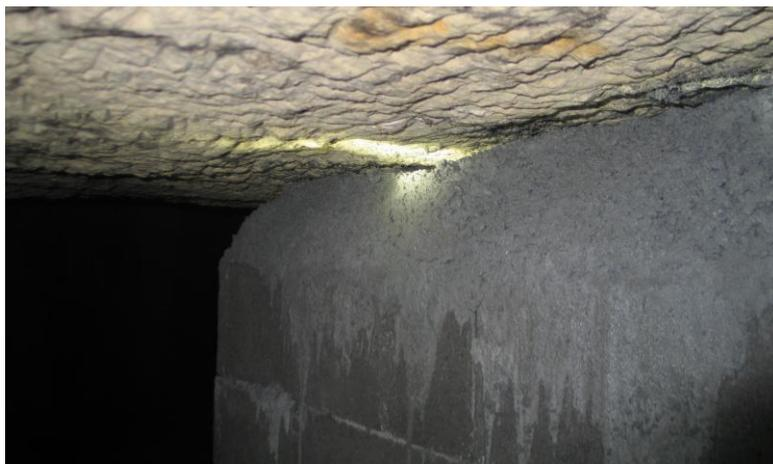
*Photographie 17 : Décollement entre le toit et le pilier coffré (carrière de Saumur, 49)*
