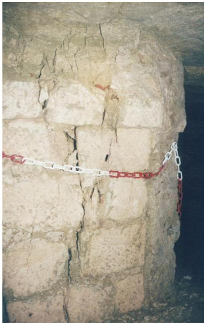
*Photographie 18 : Fissuration des moellons d'un pilier maçonné (carrière de Laon, 02)*
