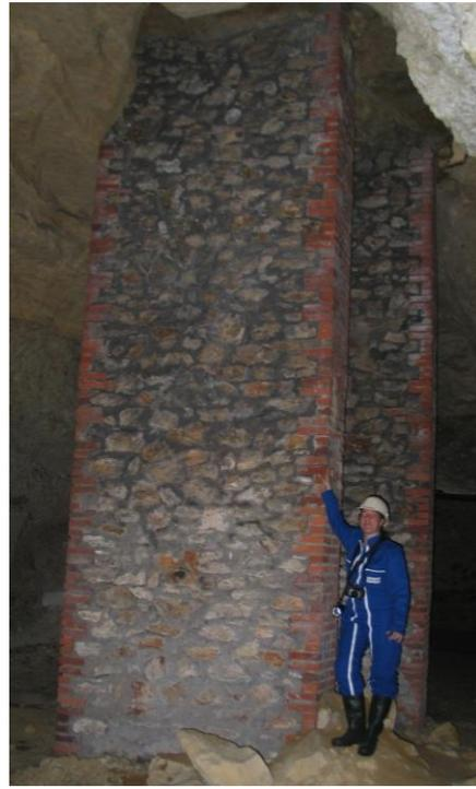
*Photographie 2 : Pilier maçonné dans une carrière de tuffeau à Saint Avertin (37)*
