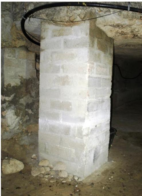
*Photographie 3 : Pilier maçonné dans une carrière de calcaire à Saint-Maximin (60)*
