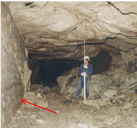
*Photographie 22 : Ventre au droit d'un mur de confortement (carrière de Cruzille, 63)*
