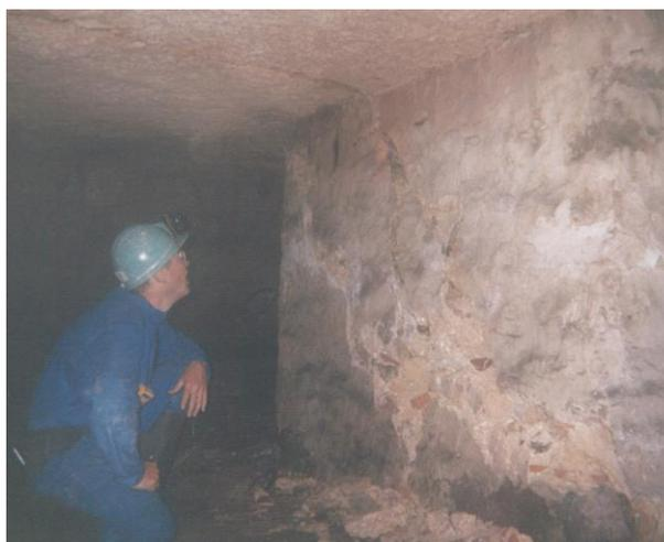
*Photographie 25 : Altération du mortier d'un
