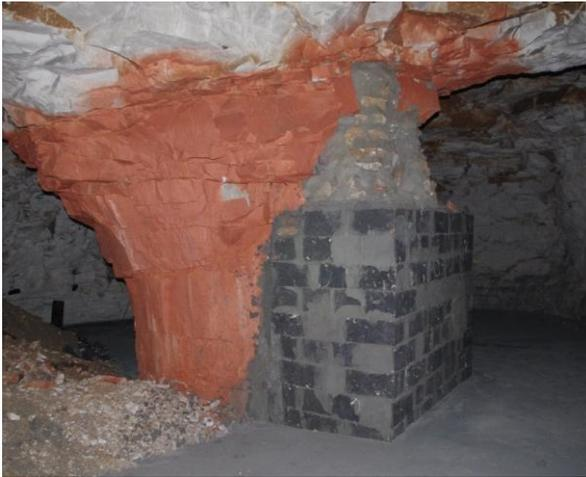
*Photographie 11 : Pilier naturel conforté en maçonnerie mixte dans une carrière de craie à Lille (59)*
