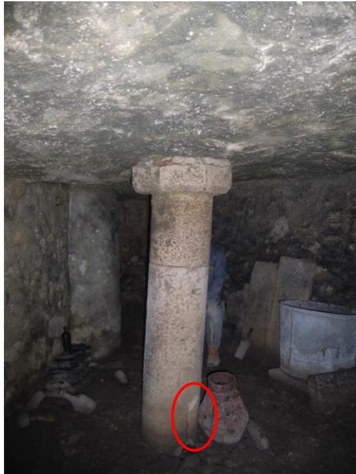
*Photographie 20 : Désaxement de la colonne et écaillage en pied (carrière de Laon, 02)*
