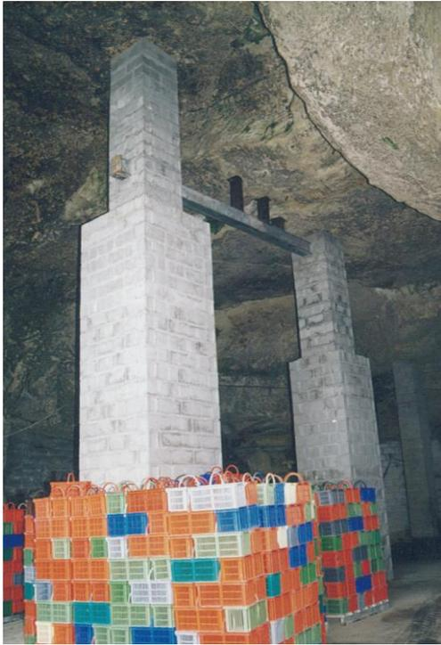
*Photographie 1 : Pilier maçonné en parpaings de béton dans une carrière de tuffeau du Saumurois (49)*
