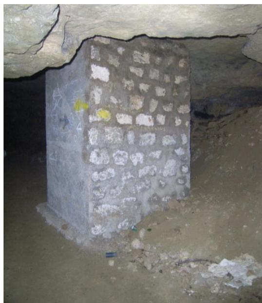
*Photographie 6 : Pilier coffré dans une carrière de sable à Laon (02)*
