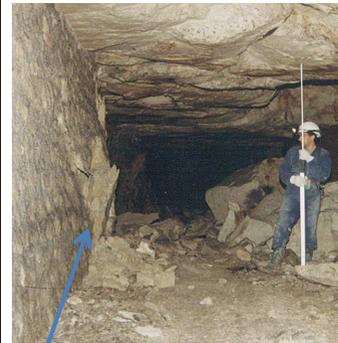
ventre puis rupture de la maçonnerie
