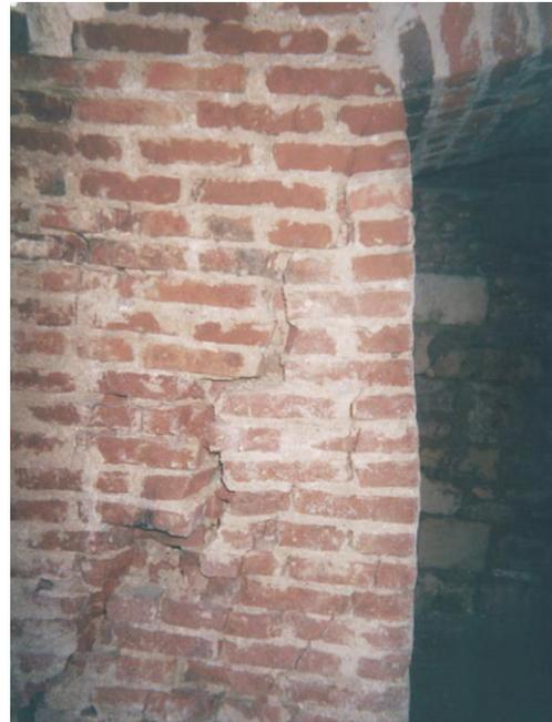
*Photographie 19 : Fissuration en « marche d'escalier » d'un pilier maçonné (carrière de Laon, 02)*
