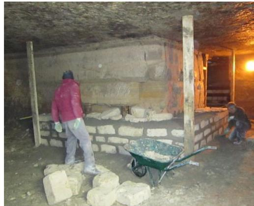
*Photographie 10 : Pilier en cours de confortement dans une carrière de calcaire à Vincennes (source : IGC)*
