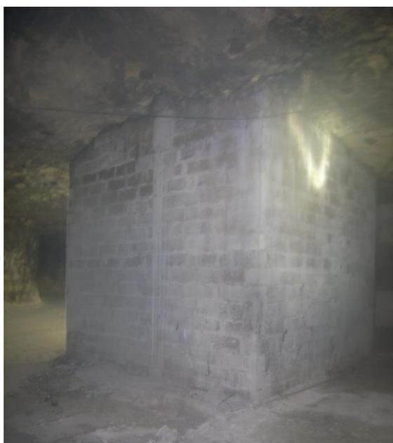
*Photographie 5 : Pilier bétonné coffré dans une carrière de calcaire à Jonzac (17)*
