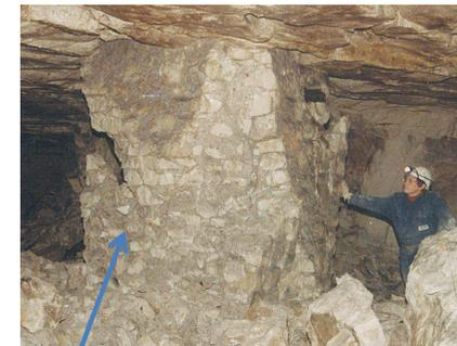
rupture de la maçonnerie
