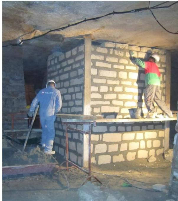
*Photographie 4 : Pilier maçonné dans une carrière de calcaire à Vincennes (source : IGC)*
