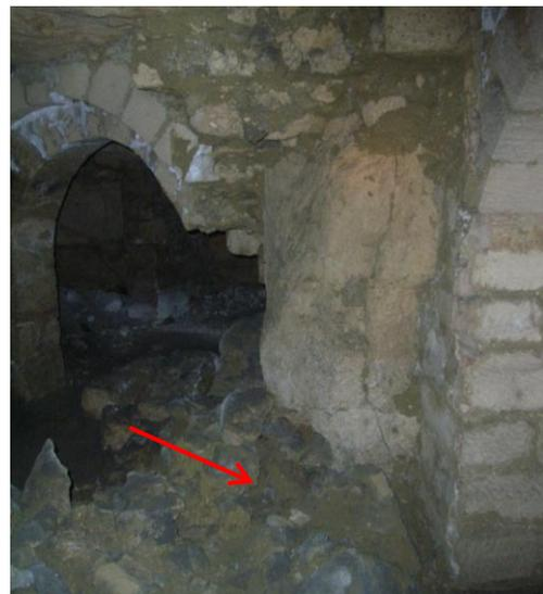
*Photographie 23 : Rupture du confortement en maçonnerie (carrière de Laon, 02)*
