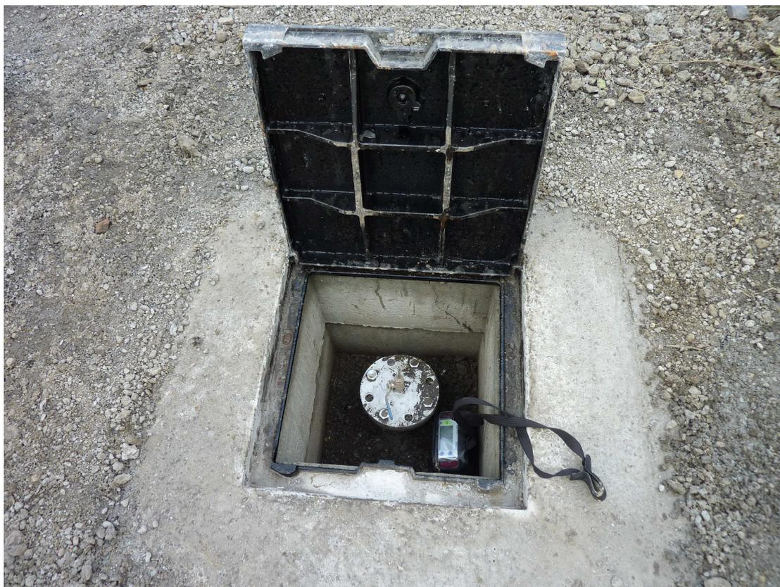
Photo A7-1. Tête de sondage fermée, équipé d'un piquage pour les mesures gazeuses.
