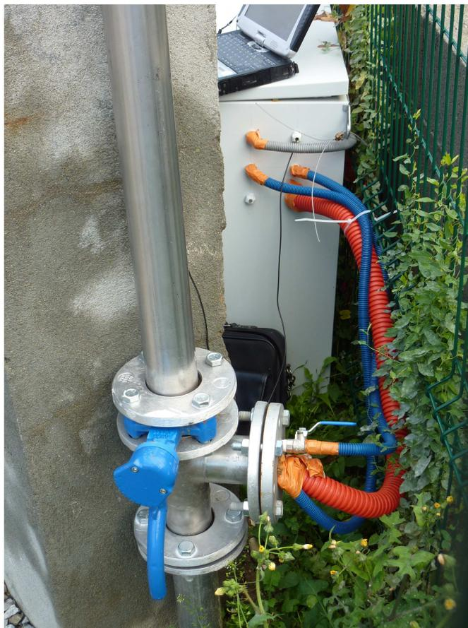
Photos A7-3 et A7-4. Event et station de mesure en continu des paramètres gazeux sur un sondage de contrôle débouchant vers un réservoir post-minier non ennoyé.
