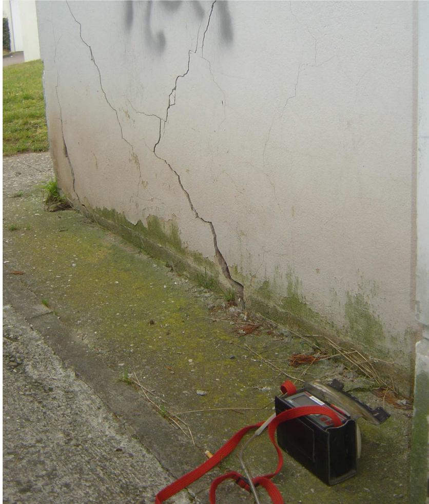
Photo A6-11. Contrôle de la présence de gaz de mine au droit des crevasses dans la dalle du sol et dans les murs des locaux affectés par des dégâts miniers.
