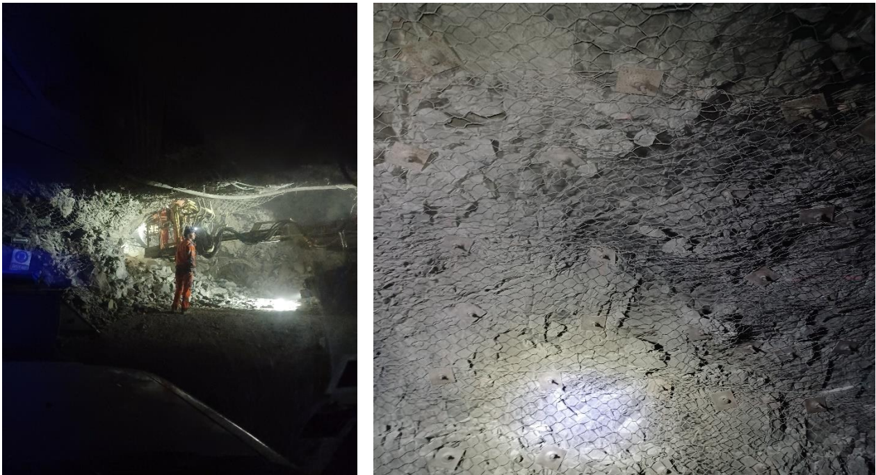
Figure 6. Grillage et boulonnage au toit d'une galerie
