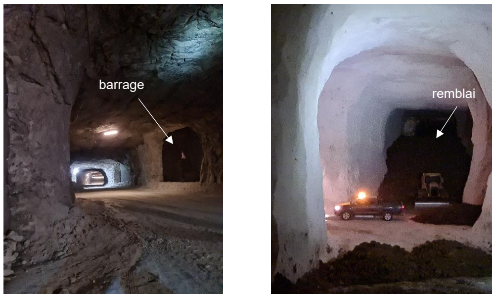
Figure 1. Freins aérauliques : barrage (à gauche) ou remblai (à droite) [source : Carrière SAMIN]
