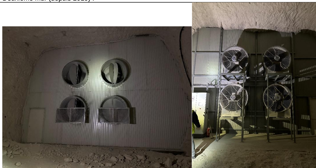
Figure 4. Vues des murs de ventilation pour l'aérage primaire du site C
