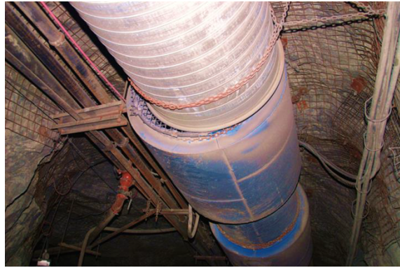
Figure 5. A gauche : gaine de ventilation souple pincée par un passage de câbles ; à droite, ventilateur auxiliaire et gaine souple en série, désaxés et trop proches (source : Auxiliary Ventilation: Good Installation and Maintenance Practices for Miners, Workplace Safety North, 2021)
