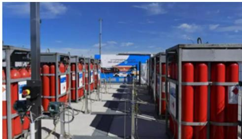
Des bouteilles de 50 litres assemblées en cadre de 9 à 18 réservoirs destinées à des installations stationnaires ou pour le transport sous des pressions de 200 bar
