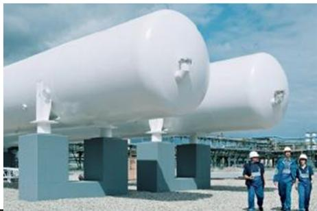
Des cuves de stockage de plusieurs dizaines de m<sup>3</sup> à plusieurs dizaines de bar
