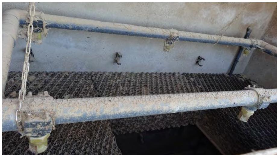
Figure 1 : Exemple de laveur individuel installé dans une installation de porcs à l'engrais en France (à l'arrêt) (Source : INERIS, 2016)
