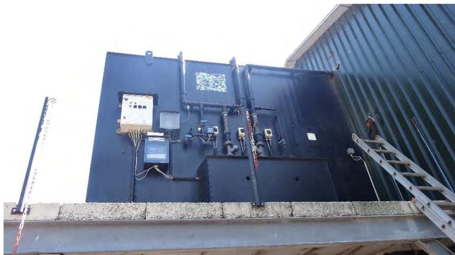
Figure 5 : Vue externe d'un biolaveur dans une exploitation porcine néerlandaise (Source : INERIS, 2017)
