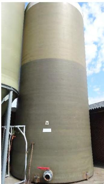
*Figure 8 : Réservoir de stockage des eaux usées acidifiées – Elevage de volailles reproductrices aux Pays-Bas (Source : INERIS ; 2017)*
