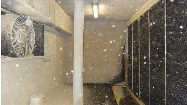
Figure 7 : Chambre de pression en amont d'un laveur acide dans une exploitation avicole aux Pays-Bas (Source : INERIS, 2017)
