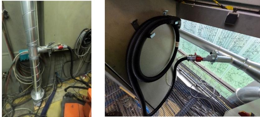
Figure 36 : Dispositif d'aspiration relié aux installations de filtration
