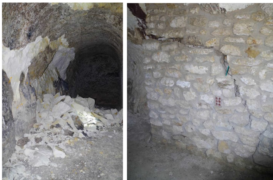
Figure 7 : Dégâts constatés dans la carrière de Royer à la suite des épisodes pluvieux exceptionnels de 2016 (Kreziak & Cherkaoui, 2016).
