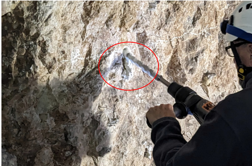
Figure 26 : Transformation de la craie en boue lors de la foration
