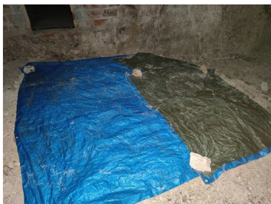
Figure 59 : Bâche installée sous le puits
