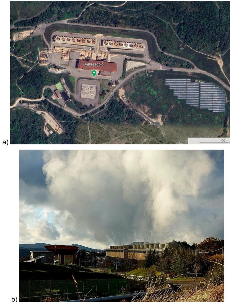
Figure 38 : centrale de Valle Secolo a) vue aérienne (Google Earth) et b) vue d'ensemble de la centrale, avec en premier plan les tours de refroidissement (Photo Ineris, Décembre 2023).
