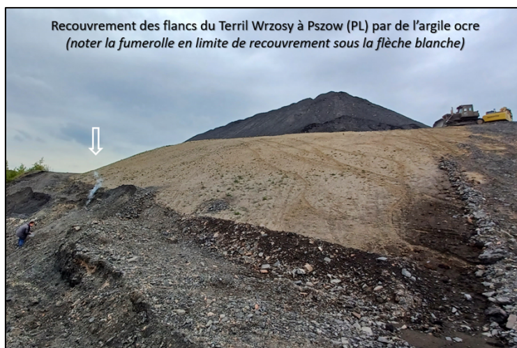
Figure 8 : Recouvrement des flancs du terril Wrzosa à Pszow en 2024
