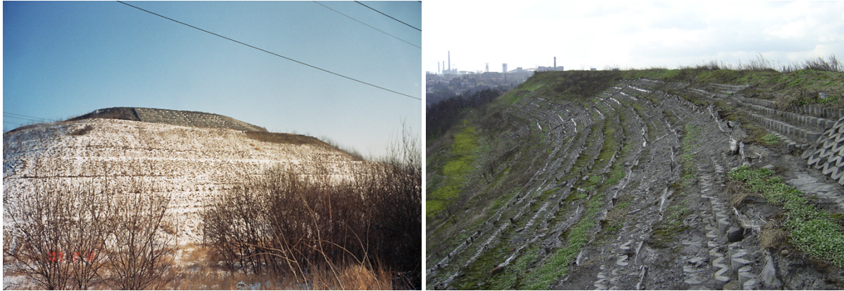
Figure 6 : Tentative de scellement du terril Rymer Cones en Pologne par des plaques de béton et des cendres volantes (à gauche) et vue du sommet (à droite) (Misz-Kennan et Tabor, 2015)
