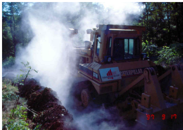
Figure 11 : Creusement d'une tranchée coupe-feu en 1997 sur la Verse des Prés à Cransac, Aveyron (Paquette et Degas, 2016)
