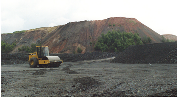
Figure 16 : Compaction des résidus récents du terril Marcel par « rouleau vibreur » (Misz-Kennan et Tabor, 2015)
