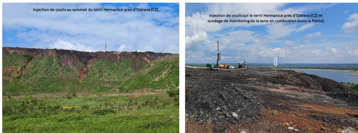
Figure 25 : Injection de coulis au droit d'une zone en combustion en 2024
