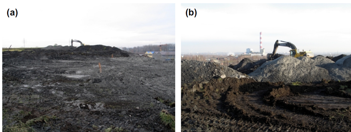
Figure 5 : Revégétalisation du sommet d'un terril houiller en combustion (a) et recouvrement par une couche de cendres volantes (b) à Welnowiec près de Katowice (Ciesielczuk, 2015)
