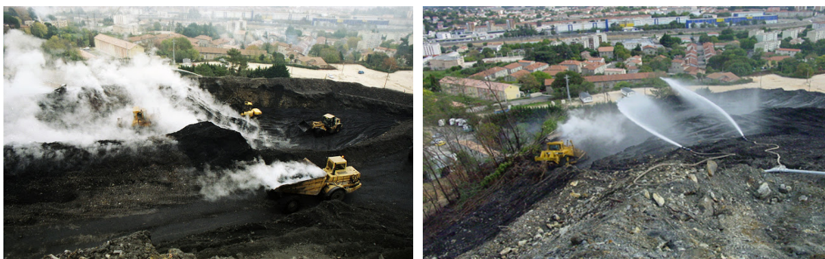
Figure 15 : Vue des opérations de défournement du terril de Rochebelle près d'Alès
