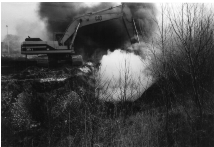
Figure 13 : Excavation du banc de résidus houillers de Brymbo au pays de Galles (Nichol et Tovey, 1998)
