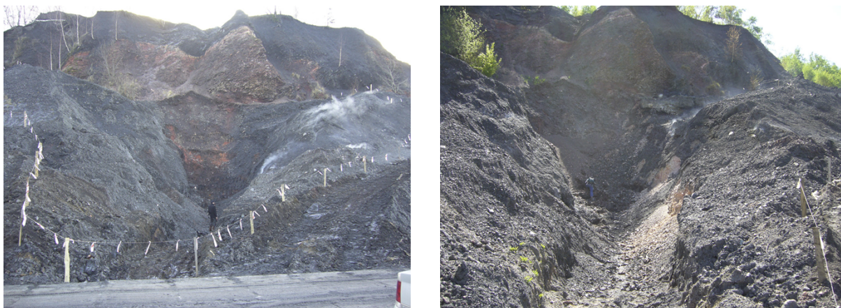
Figure 14 : Vue d'ensemble (à gauche) et en détail (à droite) des excavations réalisées en 2008 pour éteindre le feu du terril de Starzykowice (Misz-Kennan et Tabor, 2015)
