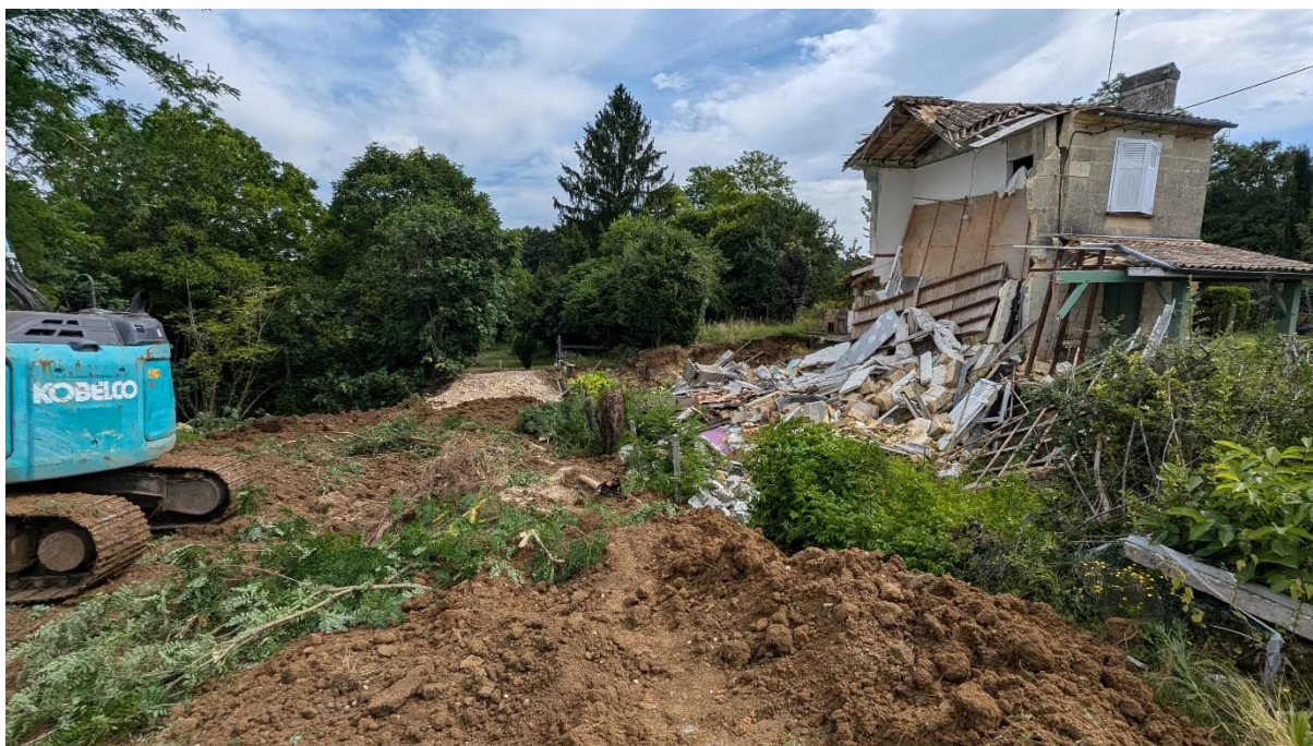
Figure 1 : Début des travaux de comblement-sécurisation dans le jardin de la propriété impactée par l'effondrement du 10 mars 2024
