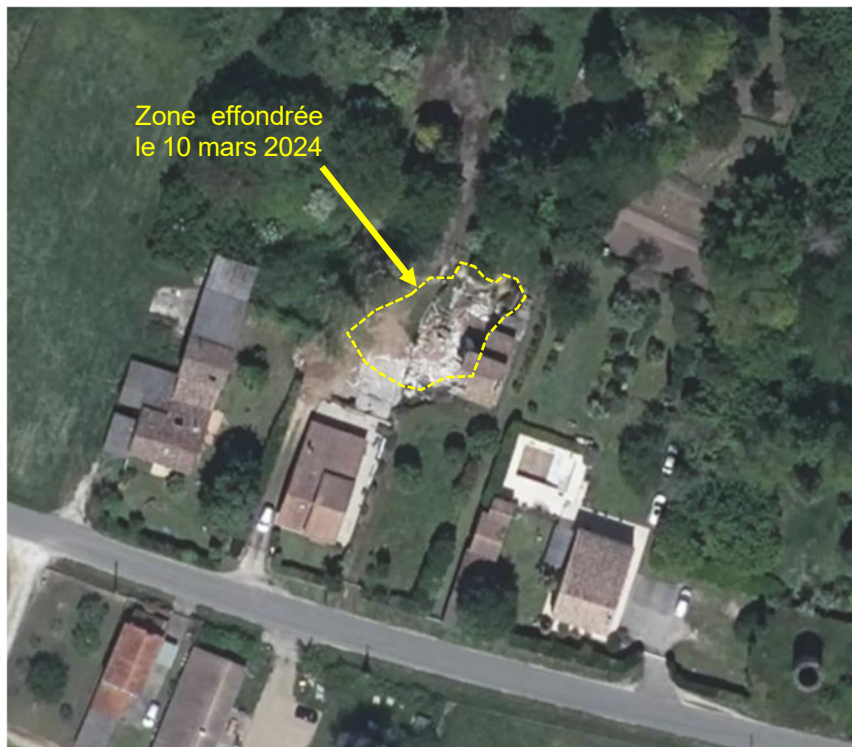
Figure 8 : Vue aérienne de l'effondrement (orthophotographie IGN du 11/05/2024).
