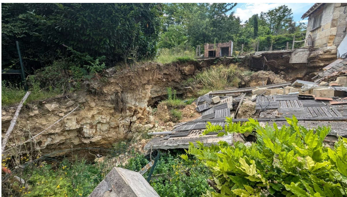
Figure 2 : Bord de l'effondrement de la carrière « Le Moulin à Vent ».
