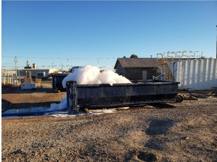
Figure 25 : Mélange de remblai : sable, mousse et saumure dans des camions boueurs [68]
