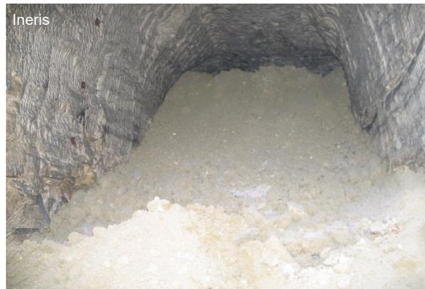
Figure 12 : Exemple de remblayage au sein d'une carrière de gypse (77)
