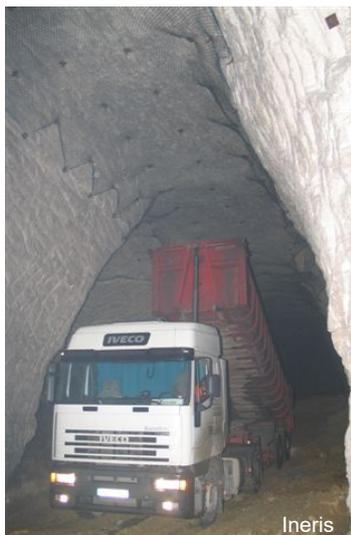
*Figure 7 : Déversement dans la carrière souterraine de Livry-Gargan (95)*
