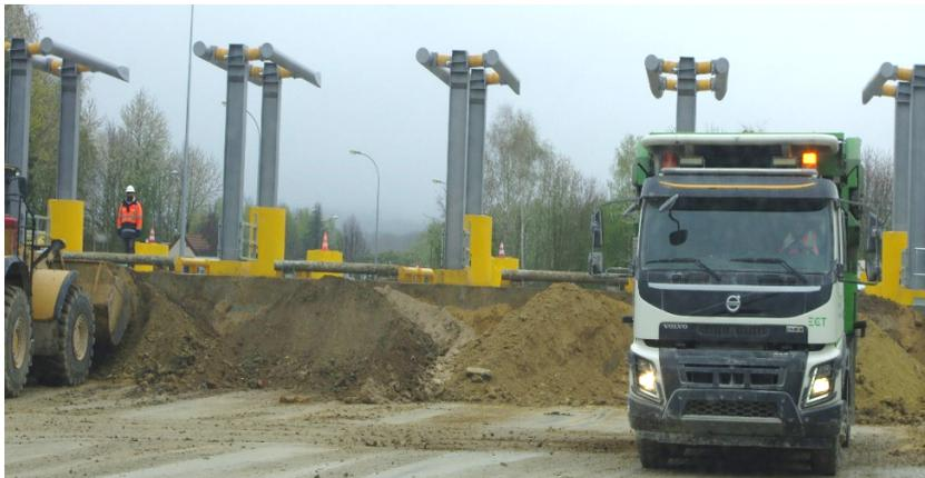
*Figure 2 : Exemple d'une plateforme de transit pour le déversement du remblai sur la carrière de gypse de Montmorency (95)*
