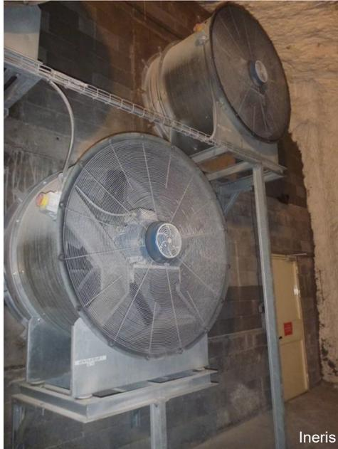
Figure 9 : Exemple de ventilateurs couplés en carrière souterraine
