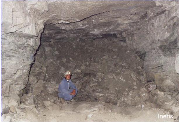
Figure 10 : Exemple de remblayage au sein de la carrière de gypse de Grozon (39)
