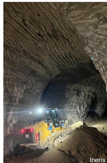
*Figures 8 : Remblayage direct par le fond avec des engins mécanisés dans la carrière de gypse de Montmorency (95)*
