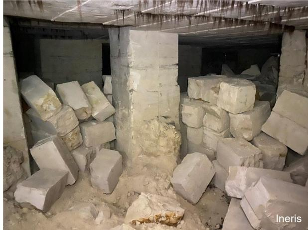
Figure 6 : Exemple de remblayage « peu efficace » avec des déchets de taille dans une carrière de pierres ornementales
