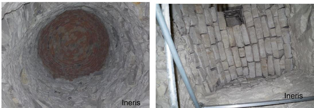
Figure 5 : Exemple des fermetures de tête de puits circulaire en briques (Pas-de-Calais) et rectangulaire par maçonnerie en moellons (Marne)
