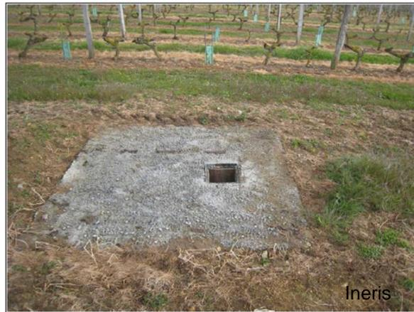
Figure 6 : Exemple d'un puits d'aération d'une ancienne carrière souterraine fermé par une dalle en béton - Saint-Cyr-en-Bourg (49), 2012 (Cerema)
