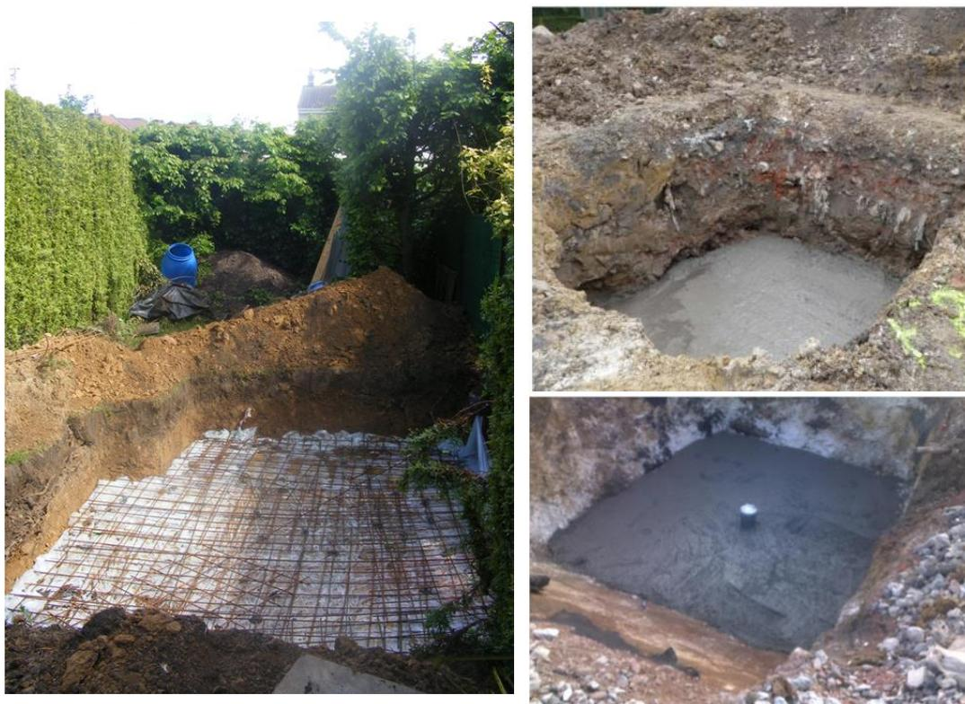
Figure 14 : Réalisation d'une dalle en béton – au-dessus de tête de puits (Ville de Lille – services de carrières)
