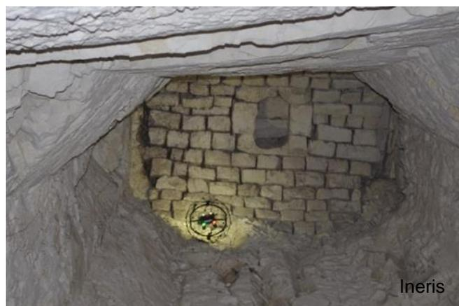
Figure 13 : Inspection par drone d'une tête de crayère (Marne)
