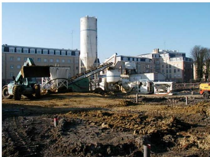
Figure 51 : Centrale d'injection pour la consolidation d'anciennes carrières du Nord-Pas-de-Calais
