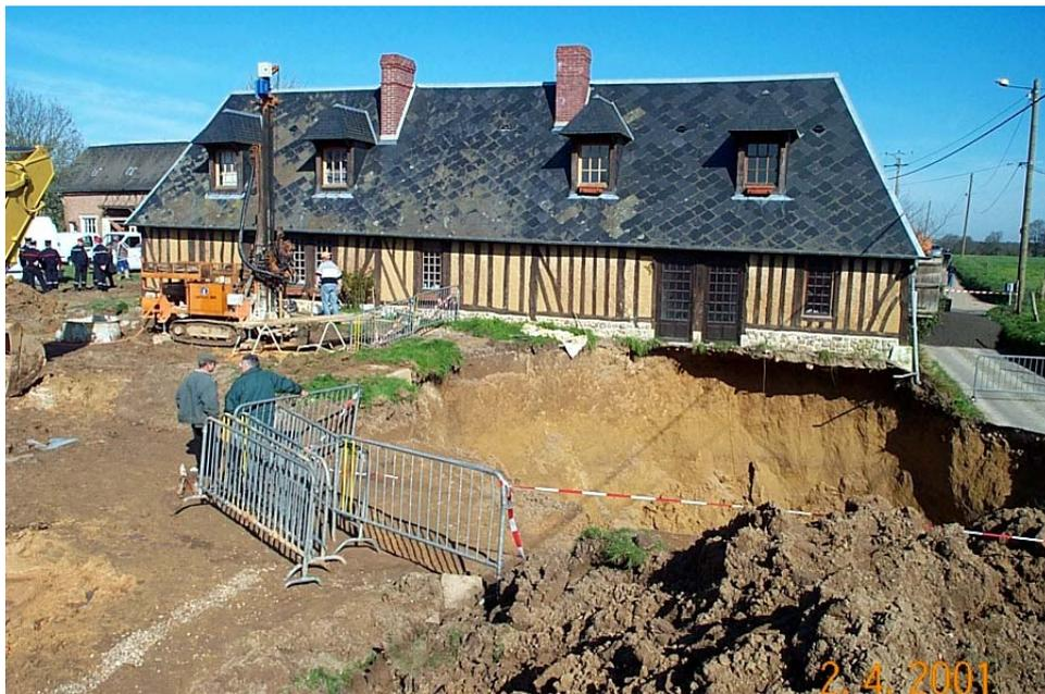
Figure 12 : Accident dû à la rupture d'une marnière dans l'Eure (document LCPC)
