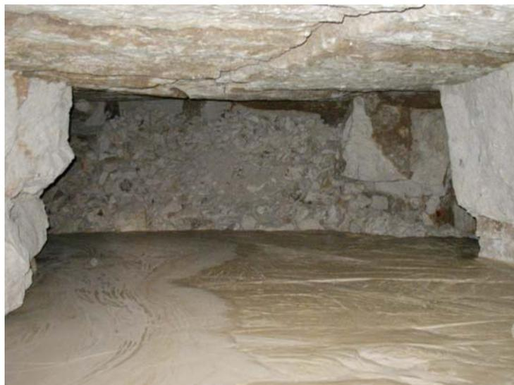
*Figure 49 : Mise en place du remblai hydraulique*
