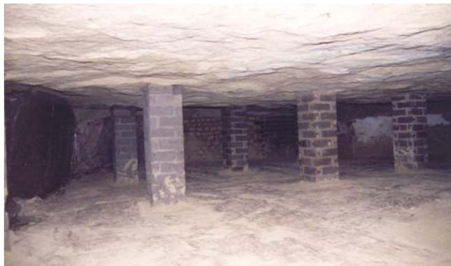
*Figure 37 : Exemple de petits piliers en parpaings pleins trop élancés*
