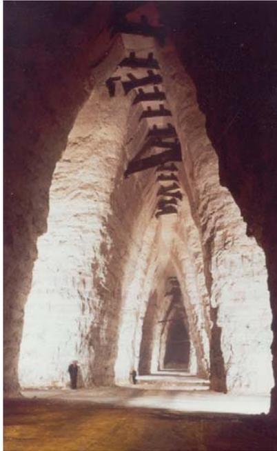
Figure 5 : Exploitation de gypse de l'Est Parisien à galeries trapézoïdales
