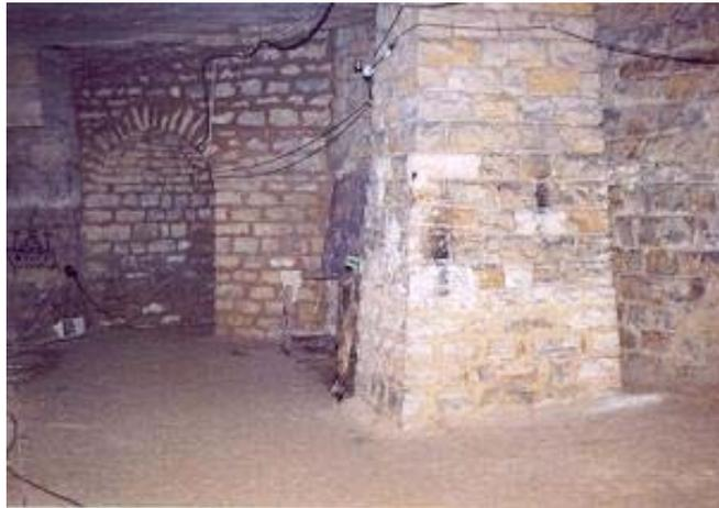
*Figure 36 : Consolidation par piliers maçonnés (carrière de la Brasserie, Vincennes)*
