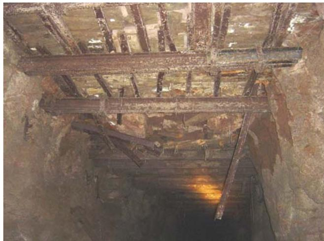
Figure 31 : Renforcement du toit d'une galerie par des cadres métalliques
