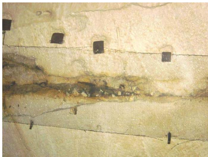
Figure 28 : Renforcement d'un passage karstique au toit par boulonnage
