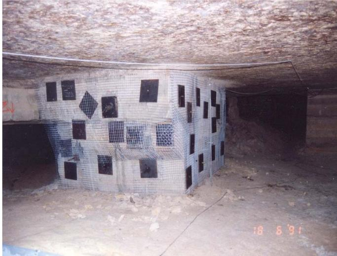
Figure 34 : Pilier renforcé par boulonnage, avec grillage (carrière de la Brasserie, Vincennes)
