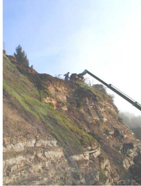
Figure 57 : Remplissage d'un fontis par de la mousse thermodurcissable et mise en place d'une couverture végétale (Conflans Ste-Honorine, Val-d'Oise)
