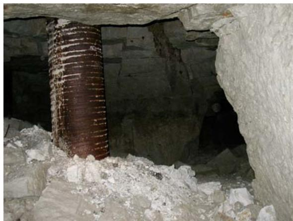
Figure 62 : Pieux de fondation traversant une cavité souterraine
