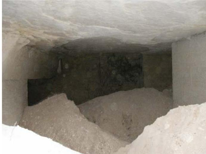
Figure 42 : Remblayage partiel avec mise en place par le fond
