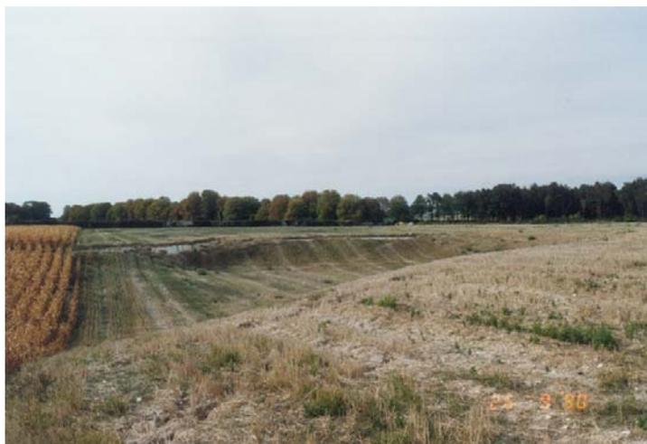
Figure 11 : Effondrement généralisé à l'aplomb d'une carrière de craie (Indre-et-Loire)
