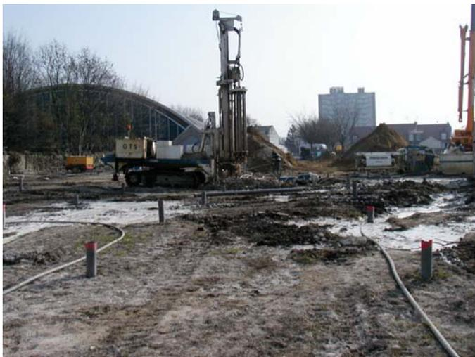
*Figure 38 : Reconnaissance des vides par forage avec diagraphies*
